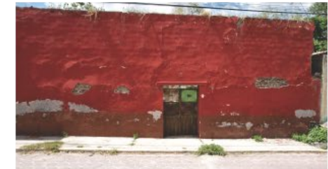
Vista de fachada con sistema constructivo tradicional en donde solo queda la propia fachada sin construcción al interior, ubicada sobre la avenida López Mateos.
