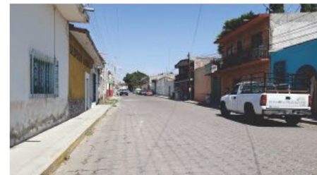
Vista de la calle 2 sur entre avenida de la Juventud y calle 5 oriente en donde se observan inmuebles con 2 niveles construidos.
