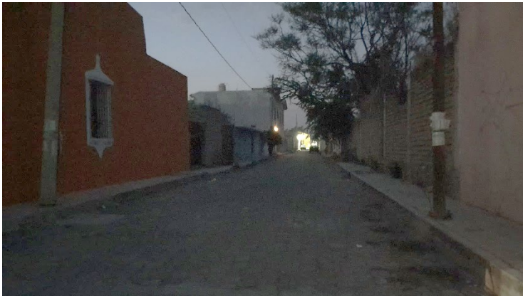
Vista de la calle del 5 de mayo en donde no funciona correctamente el alumbrado público. Fotografía: Arq. Alejandro Sánchez
