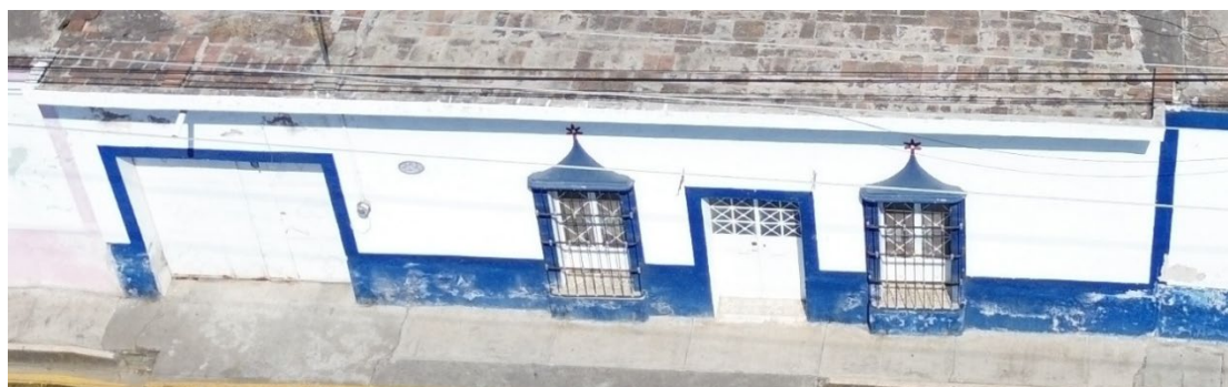
Fachada ubicada sobre la calle 4 sur, con terminados y herrerías más contemporáneas que también presenta miradores o cierros para representar una tipología más tradicional. Fotografía Alejandro Sánchez
