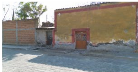
Vista de fachada con tipología tradicional, ubicada sobre la calle 4 norte.
