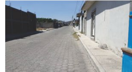
Vista de la calle 2 poniente hacia el poniente, desde el cruce con la calle 2 norte.
