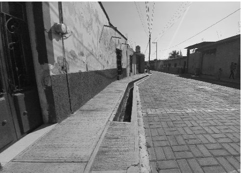
Vista de acequia sobre la calle 4 sur, cubierta con concreto para permitir el libre acceso a la puerta de una vivienda. Fotografía: Alejandro Sánchez
