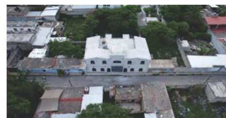
Vista de una construcción de 2 niveles ubicada sobre la calle de 5 de mayo, la cual empieza a cambiar el perfil urbano de las manzanas de esta zona.
