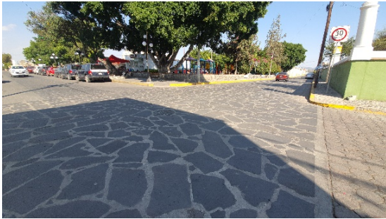
Cruce de la Av. De la Juventud y la calle 2 sur en donde se pueden apreciar 3 distintas texturas en el arroyo vehicular piedra, adoquín y concreto estampado. Fotografía: Alejandro Sánchez
