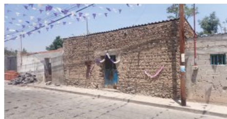
Vista fachada con sistema constructivo tradicional sobre la calle 3 sur.
