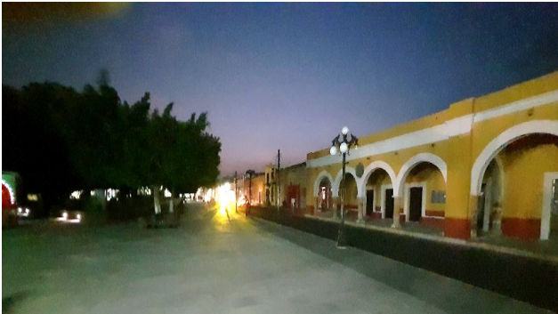
Vista de la plaza central con luminarias tipo dragón sin funcionar. Fotografía: Arq. Alejandro Sánchez
