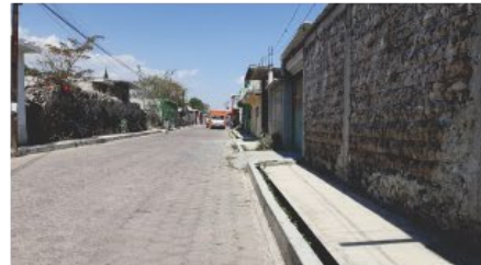
Vista de la calle 23 norte hacia el norte de la zona C.
