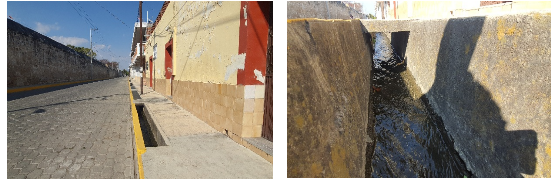
Acequia en funcionamiento ubicada sobre la calle 4 sur, y vista interior de la misma donde se aprecia la corriente de agua limpia. Fotografía: Arq. Alejandro Sánchez
