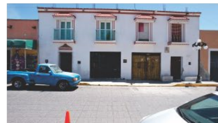
Vista de una construcción de 2 niveles ubicada sobre la avenida López Mateos, frente a la plaza central.
