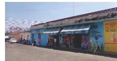
Vista de la calle de Arévalo, entre avenida Reforma y calle 3 sur, calle con mucha actividad comercial.
