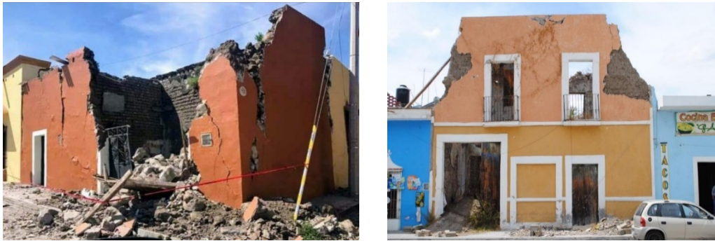
Viviendas con daños por el sismo de 7.1 en la escala de Richter del 19 de septiembre de 2017, Huaquechula, Puebla, Imagen: Silverio Reyes
