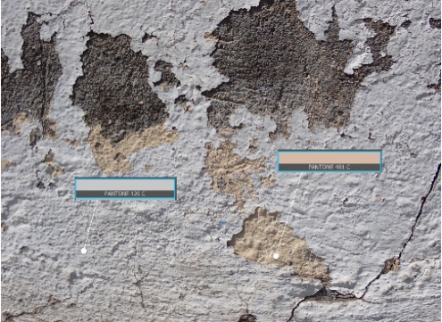
Imagen, identificación de capas de color existente en muros de fachada superficies. Fuente: Arq. Alejandro Sánchez.
