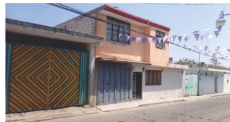
Vista de la calle 3 sur con edificaciones que rompen la continuidad de los perfiles urbanos originales..
