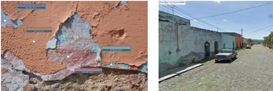
Imagen, identificación de capas de color existente en muros de fachada superficies y vista obtenida de Street View (Google Earth) en donde se aprecia el color verde-agua de fachada, toma del año 2013 Fuente: Arq. Alejandro Sánchez.
