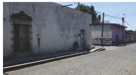
Vista fachada con tipología tradicional en el cruce de la calle 4 sur y la calle 5 oriente.
