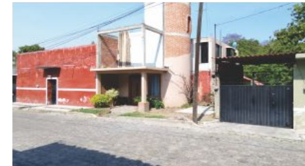
Construcción contemporánea sin termino de acabados, con 3 niveles de altura, ubicada sobre la calle 4 norte, entre avenida López Mateos y calle 2 oriente.
