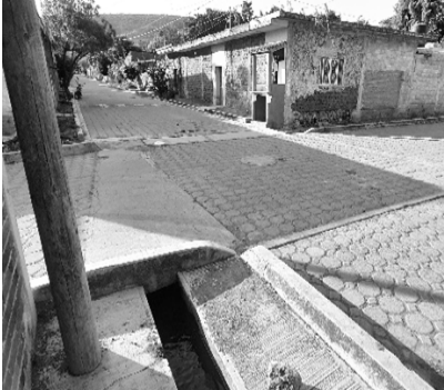
Vista de la forma de solucionar el paso de las acequias en bocacalles empezaron a cubrirse a partir de la década de los 70'. Fotografía: Alejandro Sánchez 2024.
