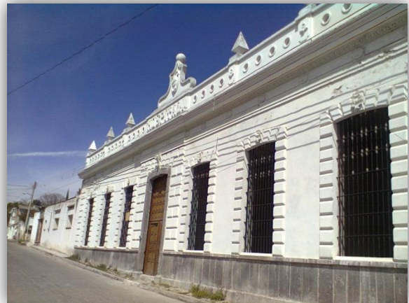
Imagen 46. Fachada del antiguo hospital
