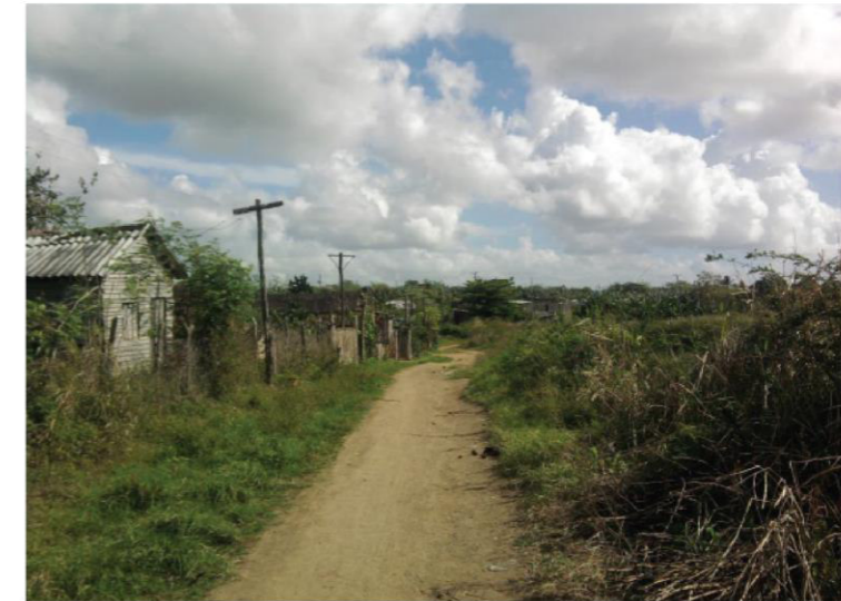
La instalación de la infraestructura se encuentra deteriorada por el paso del tiempo, además que la vegetación prevalece en gran parte de esta zona. [Toma por Lucero Bolaños Fortiz, el 19/02/2014]
