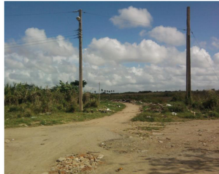
Infraestructura y luminaria que se encuentra en la zona, además de la delimitación de los caminos. [Toma por Lucero Bolaños Fortiz, el 19/02/2014]
