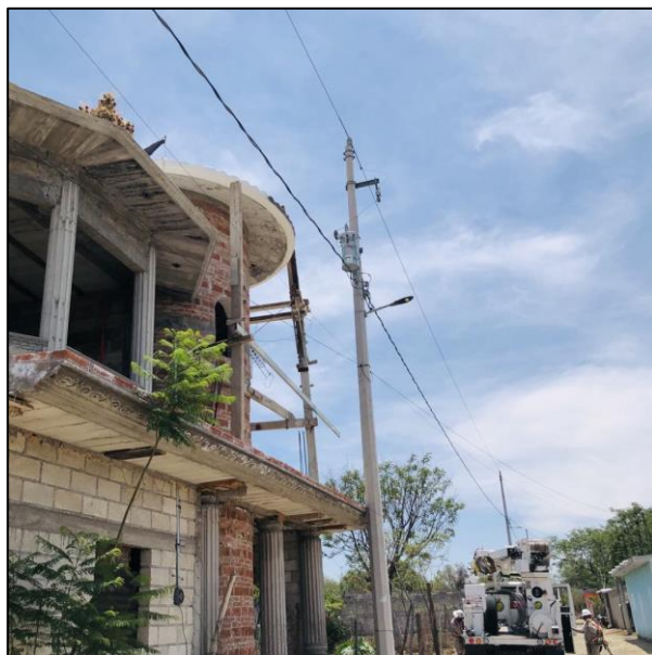
Figura 39. Transformador autoprotegido tipo poste de 10 kVA
