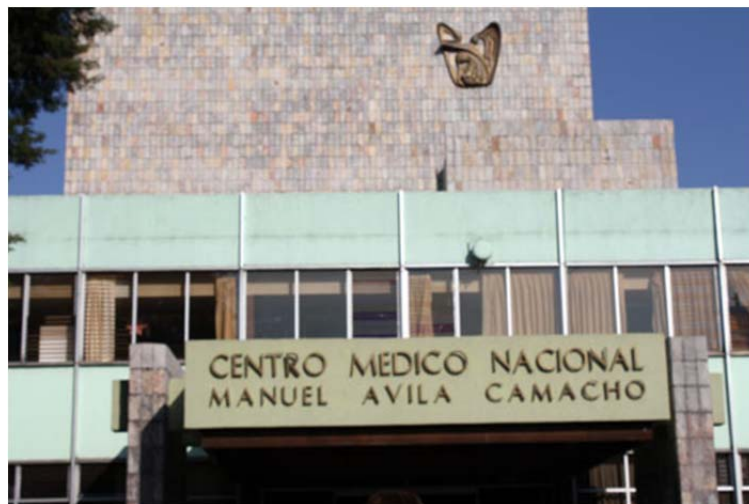
Figura 1. Entrada Principal de la U.M.A.E. Hospital de Especialidades, Puebla.
