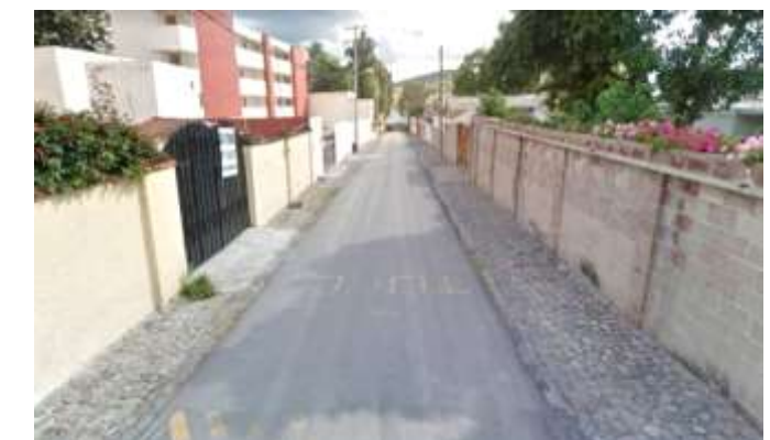
Figura 2.13.2.3 Ausencia de banqueta en el extremo derecho de la calle. Fuente: Google Maps
