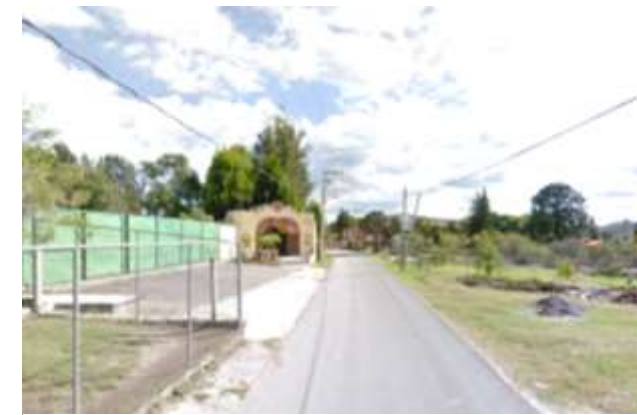
Figura 2.10.2 Vialidad primaria avimentada "Avenida Gral. Manuel Ávila Camacho. Fuente: Google Earth
