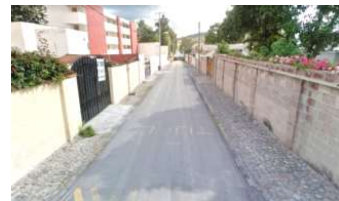
Figura 2.13.2.2 Banqueta hecha de piedra bola nivel de piso con un ancho de 70 cm aproximadamente. Fuente: Google Maps.
