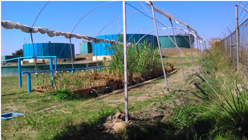
Figura 16. Sistema de humedales contruidos instalados en la PTAR de Izúcar de Matamoros.
