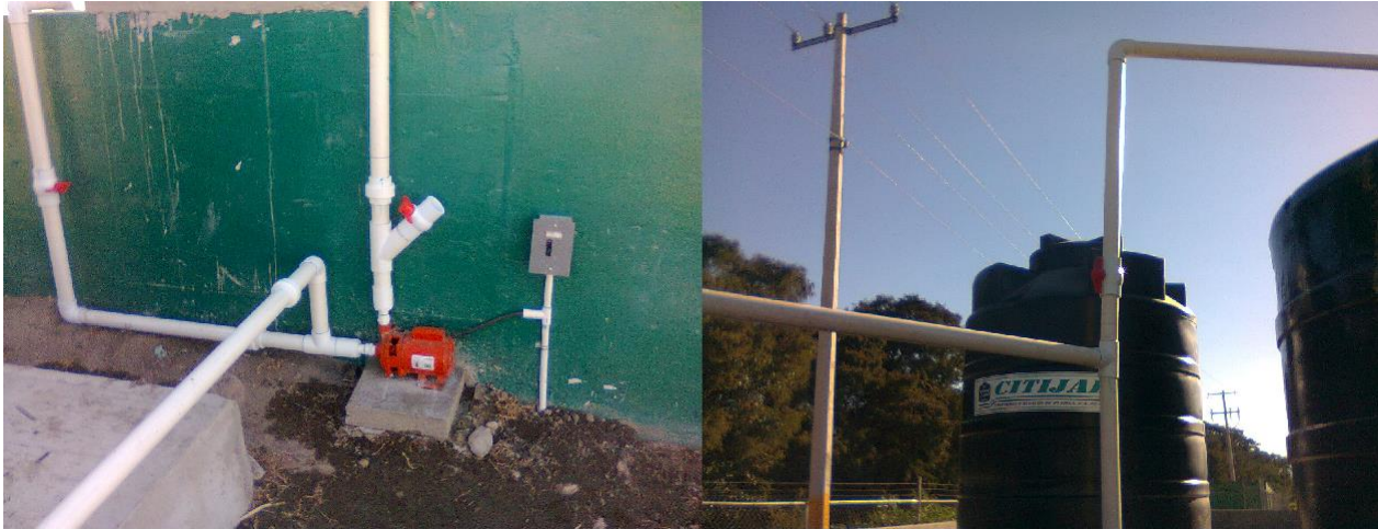
Figura 15. Colocación del sistema de alimentación.
