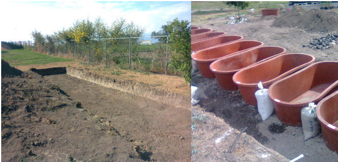
Figura 10. Acondicionamiento y colocación de las tinas para los sistemas de tratamiento.
