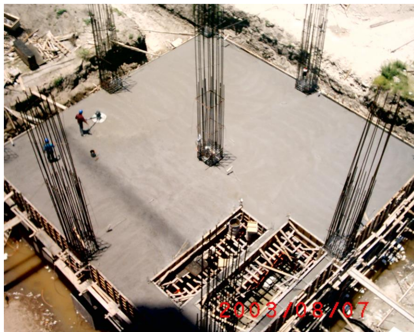
Foto 2. Concreto en cimentación
