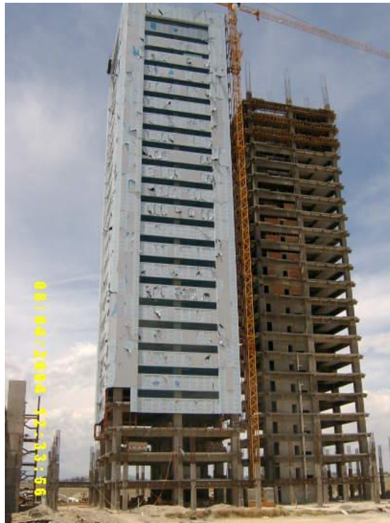
Foto 7. Concreto en columnas y losas
