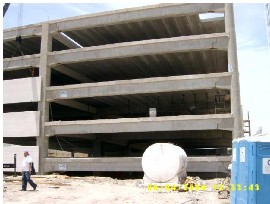
Foto 4. Concreto en columnas y losas
