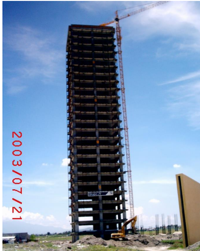
Foto 5. Concreto en columnas y losas
