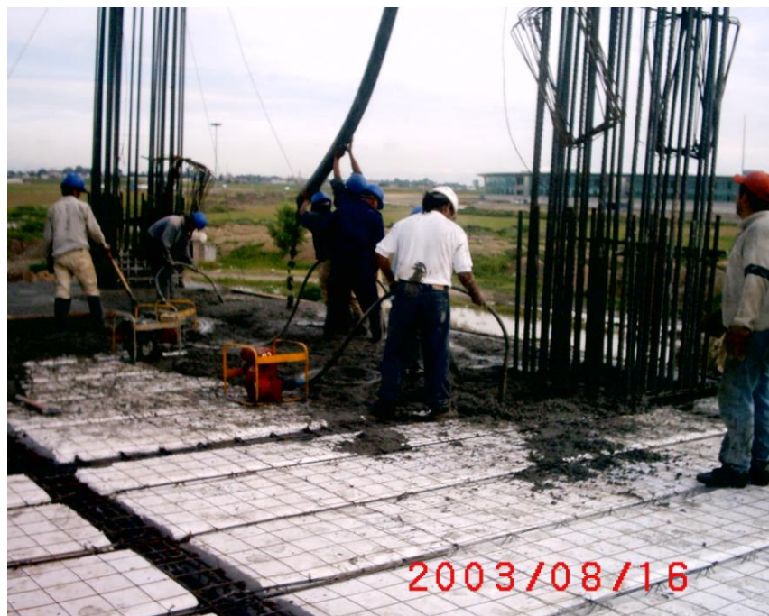
Foto 6. Concreto en columnas y losas
