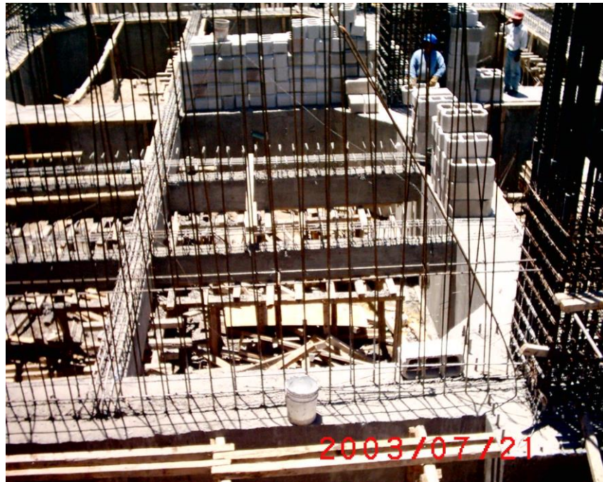
Foto 1. Concreto en cimentación
