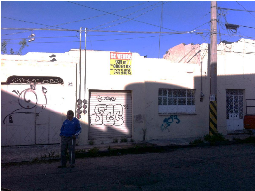
Ilustración 28.- Fachada Principal del Inmueble.
