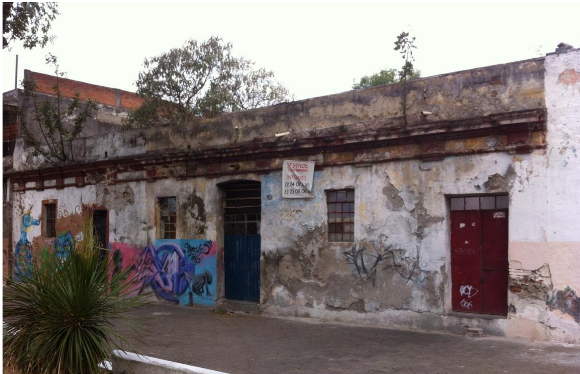
Ilustración 27.- Fachada Principal del Inmueble.
