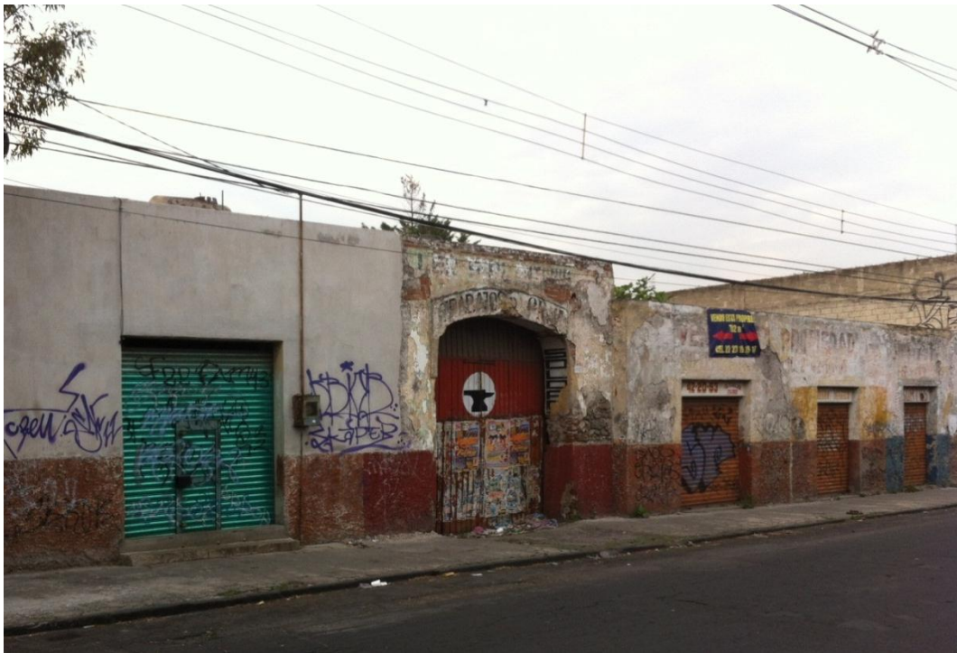
Ilustración 26.- Fachada Principal del Inmueble.
