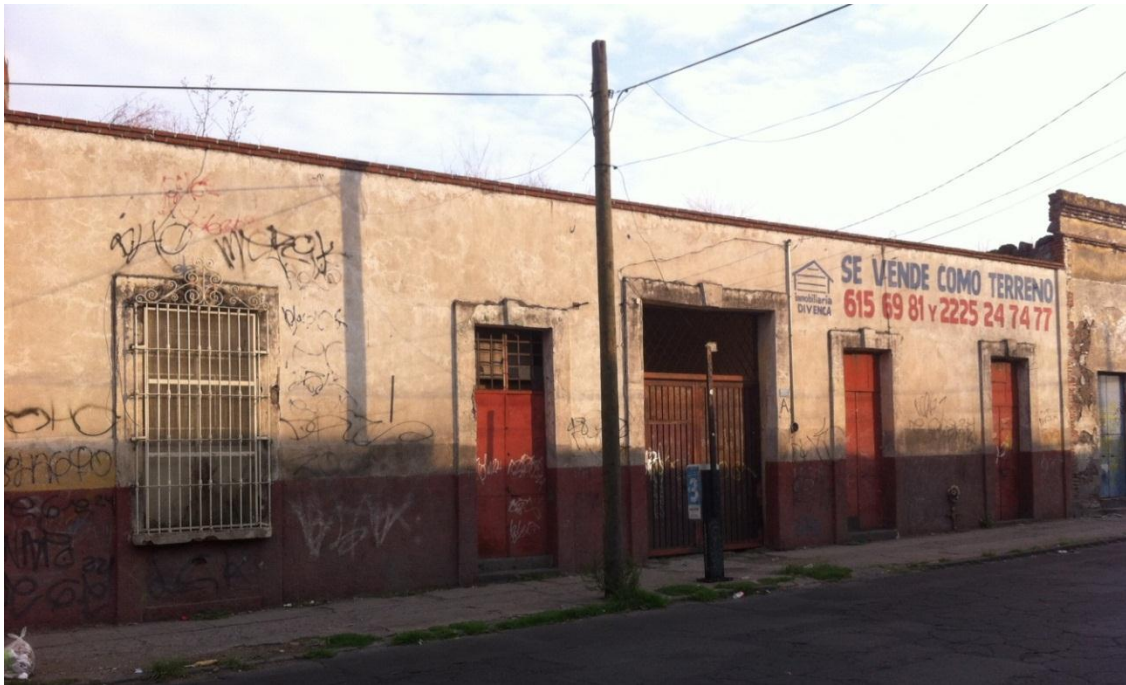
Ilustración 25.- Fachada Principal del Inmueble.
