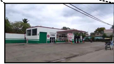
ESTACIÓN DE GASOLINA
