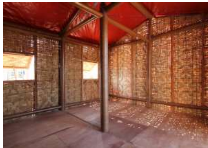
Imagen 3.4 Paper Log House en Filipinas con estructura de tubos de cartón y cerramiento de Bambú. Fuente: (SHIGUERU BAN ARCHITECTS, 2014)
