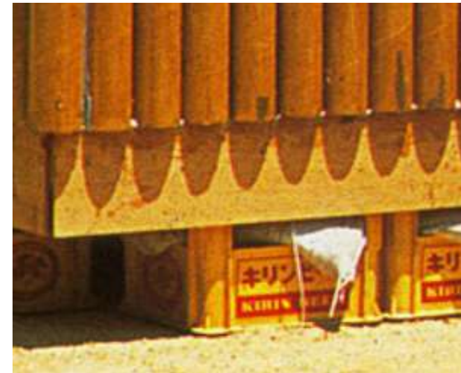
Imagen 3.5 Paper Log House, uso de cajas de cerveza como cimentación de la vivienda Bambú. Fuente: (SHIGUERU BAN ARCHITECTS, 2014)
