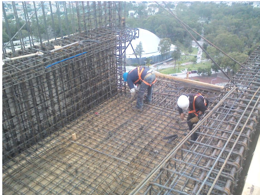
Armado de acero para foso de área de llegada
