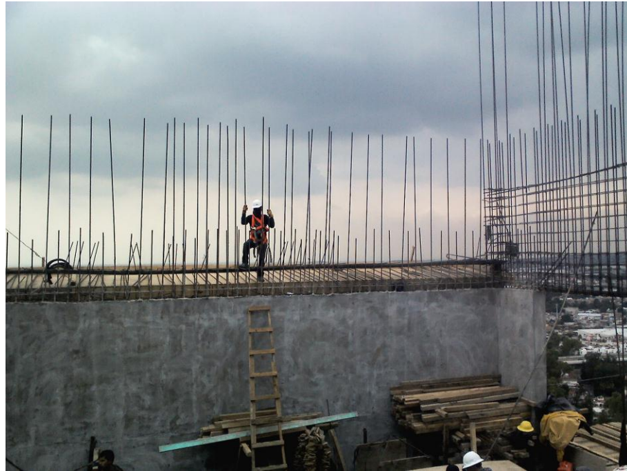
Curado de muros de concreto
