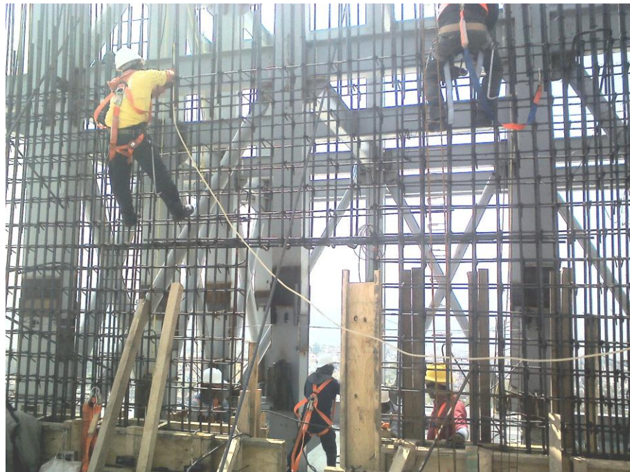
Armado de acero para muros de concreto de cuarto de máquinas
