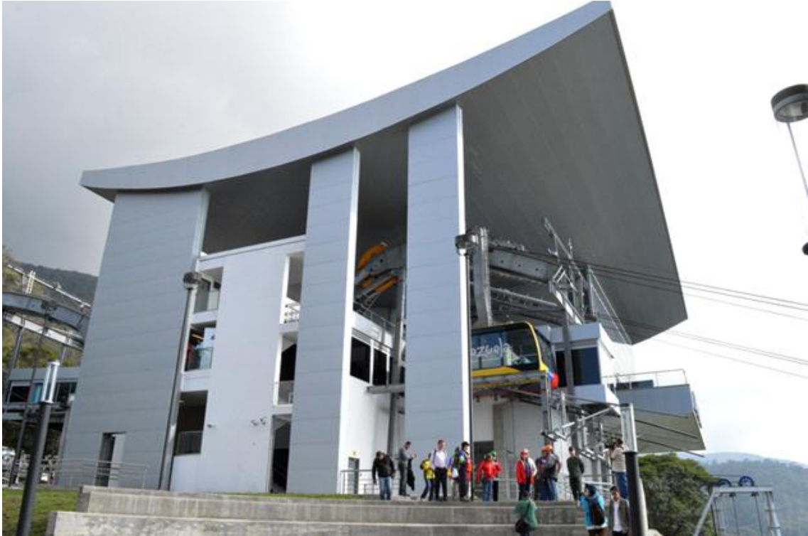
Figura No. 1. Finalizan trabajos en Teleférico de Mérida Mukumbari.
