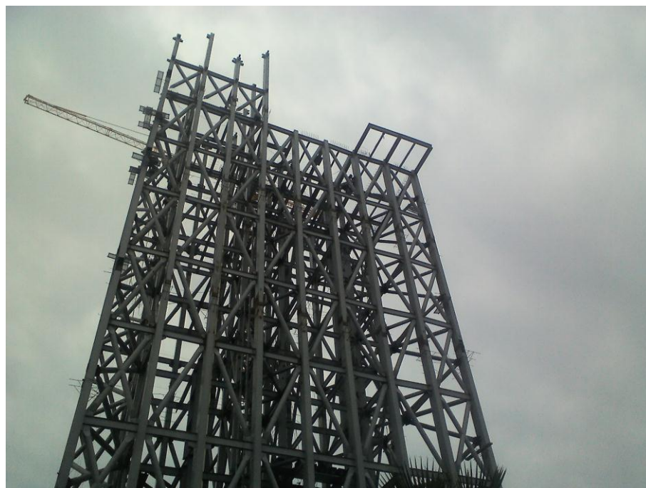
Montaje de estructura metálica
