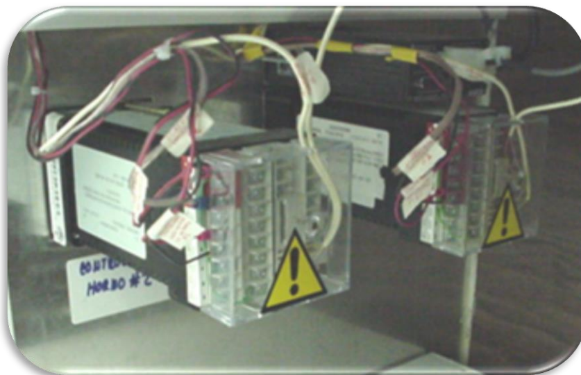
Fotografía 2.5.- Vista posterior de los controladores de Temperatura modelo 818P4 de Eurotherm para el sistema de EFL
