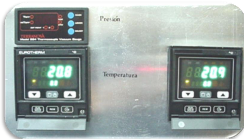
Fotografía 2.4.- Controladores de Temperatura del sistema EFL
