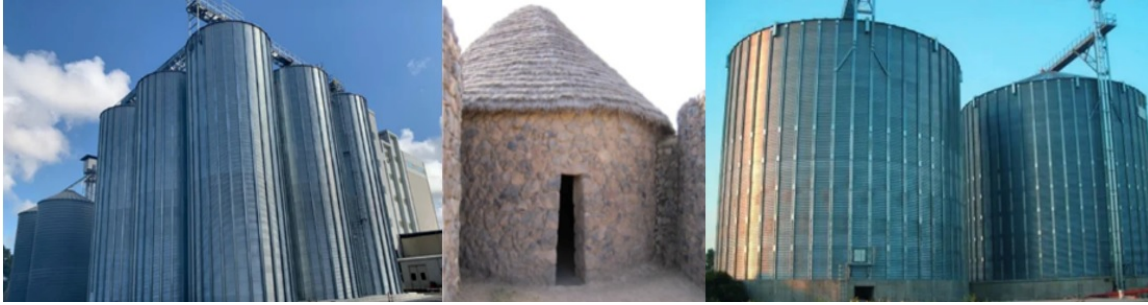
Figura 2.7: Silos de distintas capacidades utilizados para el almacenamiento de granos [28]. Estas estructuras se han utilizado a lo largo de los años, inicialmente se realizaron con rocas y tierra, pero en la actualidad, son grandes estructuras de metal. Imágenes tomadas de la referencia [28].
