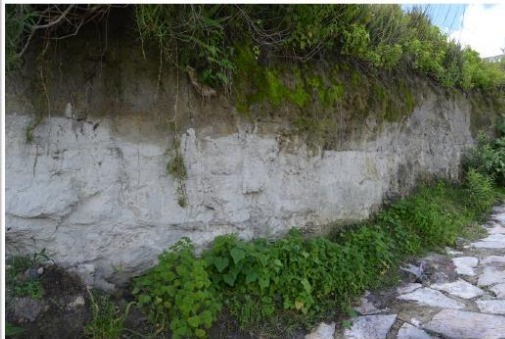
Camino junto al sitio de excavación
