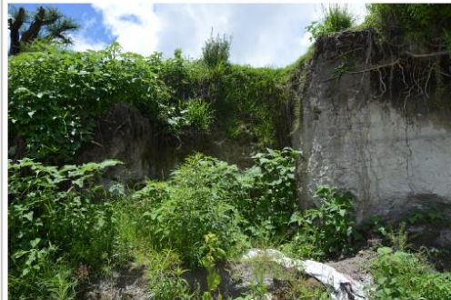
Vista general del sitio de excavación
