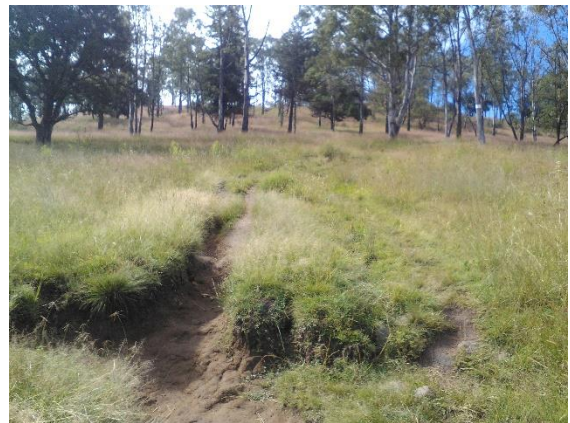
Figura 93. Zanjas realizadas para controlar la erosión.
