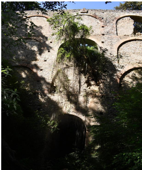
Imagen 9. Acueducto en San Gregorio Aztotoacan.
