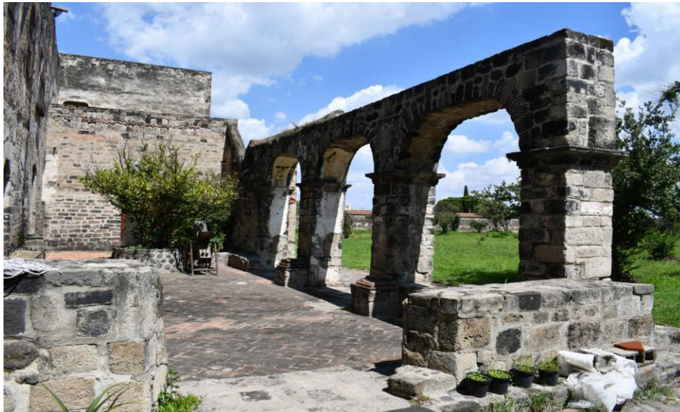
Imagen 5. Acueducto en la huerta y patio interior del Convento Franciscano de Huejotzingo
