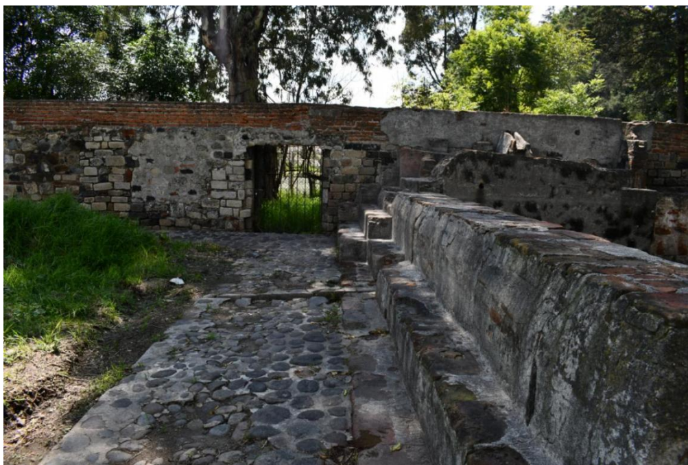
Imagen 6. Canal al interior del convento que conducía el agua del acueducto al aljibe
