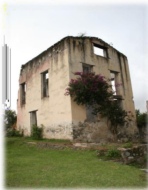
Figura No. 2.47 MUROS
