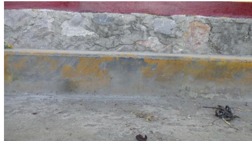
Ilustración (43). Rojas, A. (2019). Guarnición en algunas de las banquetas de 0.20 cm de alto por 0.15 de ancho. [Foto]. Elaboración propia.
