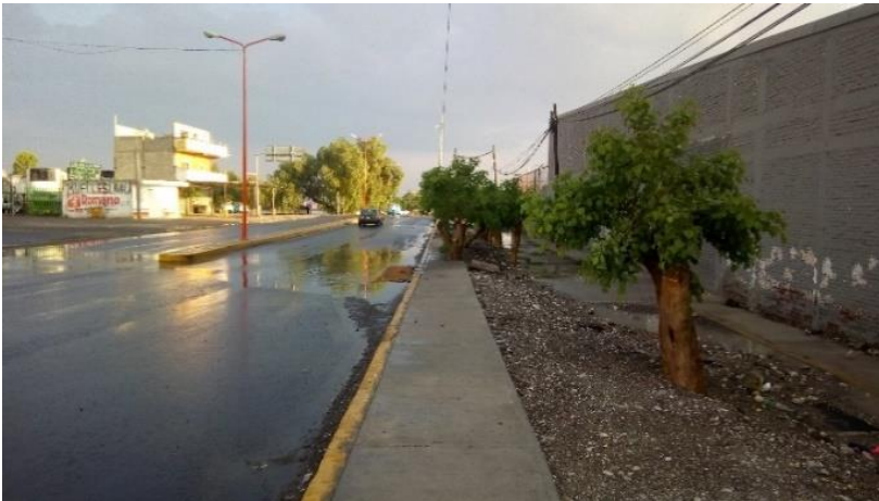
Ilustración (27). Candia, A. (2019). Encharcamiento dentro y fuera de la carretera a Tochtepec. [Foto]. Elaboración propia.
