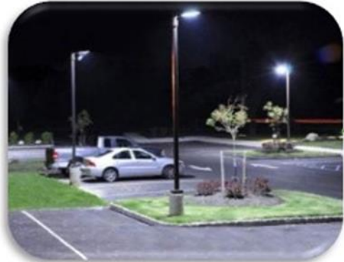
Luminarias con foto celda para isletas en estacionamiento.
