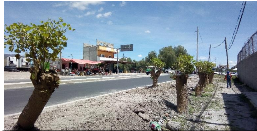
Ilustración (63). Candia, A. (2019). Las calles no cuentan con banquetas para los peatones que transitan en el área de estudio. [Foto]. Elaboración propia.
