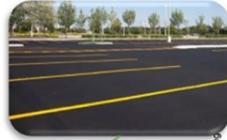
Carpeta asfáltica para área de circulación en área de estacionamiento.
