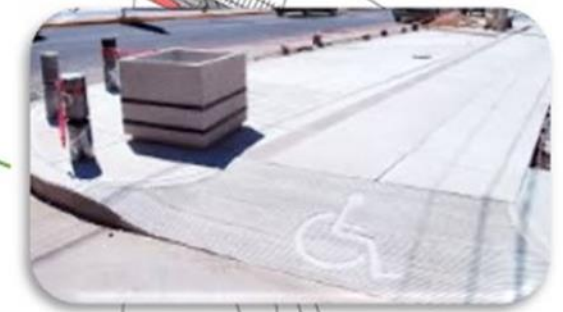
Banqueta con rampa para discapacitados de concreto simple.
