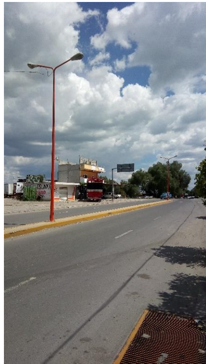
Ilustración (49). Rojas, A. (2019). Postes de luz, ubicados en el camellón de la carretera a Tochtepec. [Foto]. Elaboración propia.
