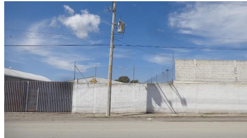
Ilustración (51). Candia, A. (2019). Poste con transformador ubicado en la calle 2 Oriente, el cual obstruye el paso del peatón en la banqueta. [Foto]. Elaboración propia.
