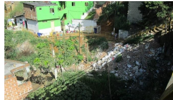
Ilustración (71). Secretaría del Medio Ambiente en Medellín. Antes de la recuperación de la Villa del Socorro, Comuna 2, Medellín. [Imagen]. Recuperado de https://www.archdaily.pe/pe/806652/130-basurales-de-las-quebradas-de-medellin-fueron-transformados-en-jardines-publicos/58bd55d8e58ece04510003b1-130-basurales-de-las-quebradas-de-medellin-fueron-transformados-en-jardines-publicos-foto
