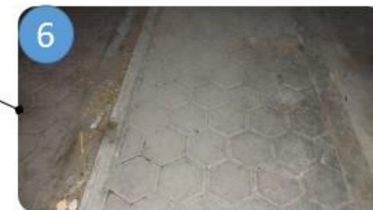
Ilustración 4. Candia, A. Camellón de 1 metro de ancho, con adoquín y guarnición.
