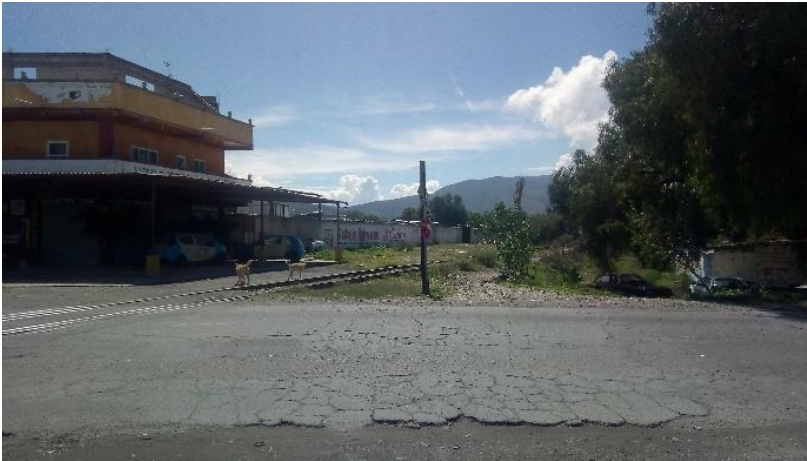
Ilustración (45). Rojas, A. (2019). Calle a Tochtepec deteriorada que muestra agrietamientos en la carpeta asfáltica. [Foto]. Elaboración propia.
