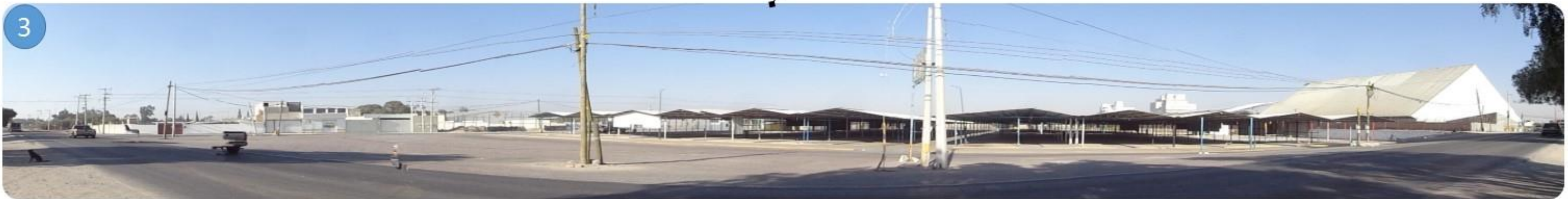
Ilustración 3. Candia, A. Panorámica del la Carretera a Tochtepec, en ella se logra a ver los postes de tendido eléctrico y transformadores, que dan mal aspecto al lugar, al igual que en el área se encuentran como 15 postes de este tipo.
