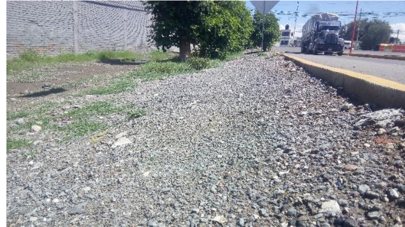
Ilustración (42). Candia, A. (2019). Guarniciones ensolvadas del lado del talud. [Foto]. Elaboración propia.
