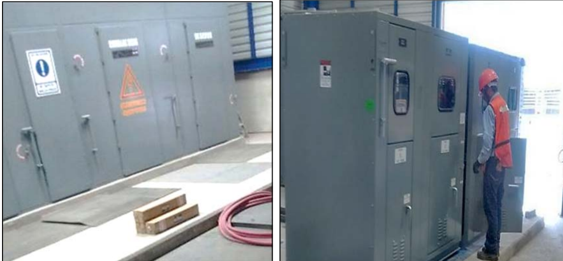
Fig. 4.9 Cuchillas Desconectoras GEP 73S09
