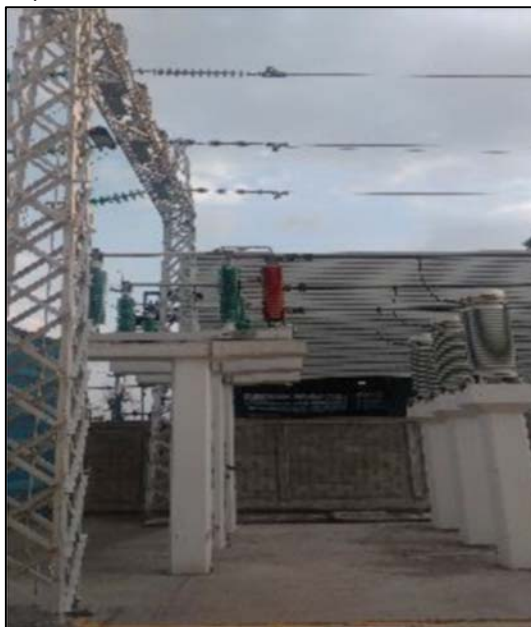
Fig. 4.4 Cuchillas Desconectoras GEP 73S09
