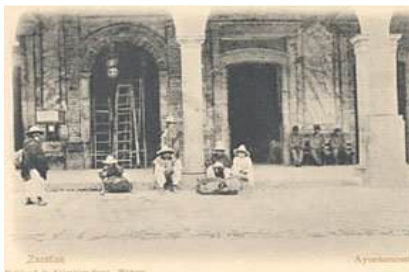
Figura 34. Imagen del Palacio Municipal de Zacatlán en construcción https://bivir.uacj.mx/postales/Postal.asp?CodBar=001413915
