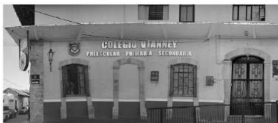
Ilustración 3 – Fachada con alteraciones tanto en su tipología como en colores y materiales, provocando ruptura en el perfil. Fuente: Irving Hernández 2024
