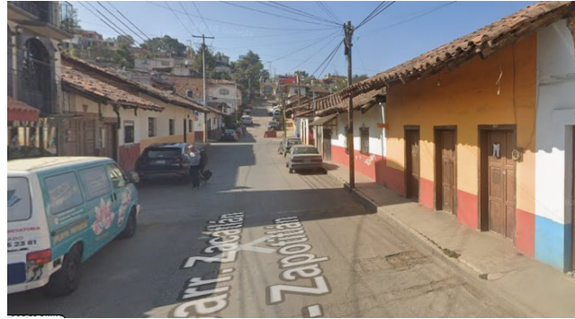
Figura 49. Perfiles Urbanos del sector 1 residencial, Fuente: Google maps
