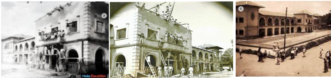
Figura 36. Vista de la construcción de la Primaria “Manuel Avila Camacho” FUENTE: https://www.holazacatlan.com/2019/03/10-imagenes-antiguas-de-zacatlan-todas_4.html
