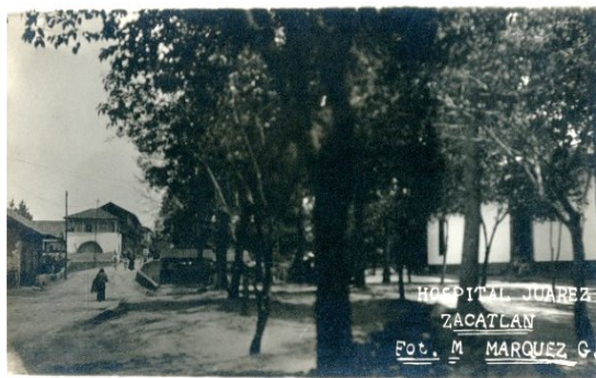
Figura 40. Antiguas instalaciones donde funcionó el "Hospital Juárez" en Zacatlán
