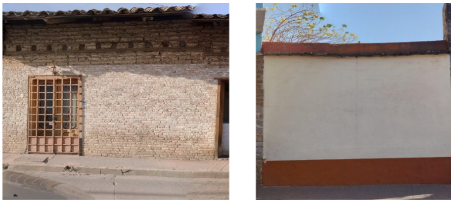
Figura 75. Imágenes de un muro de piedra, cubierta y alero terminada en tea (foto izquierda). Muro de adobe con aplanado de cal:arena (foto derecha. Sector 2 Fuente: Irving Hernández Vázquez
