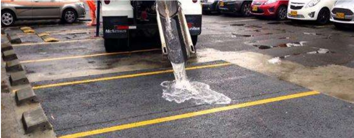
Figura 24.- Estacionamiento con concreto permeable
