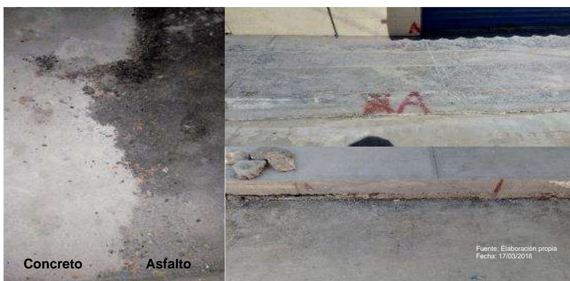
Fotografía 5.- Re encarpetado asfáltico en la calle 5 de febrero oriente
