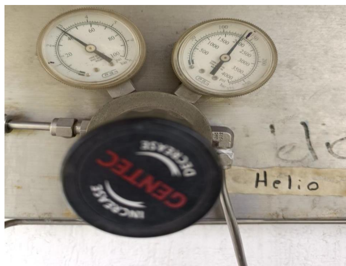
Figura 14. Válvulas de flujo externas
