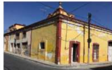
Fachada desde calle 5 Norte y 6 Poniente. Fuente: Pedro Martínez Baez, 2017.
