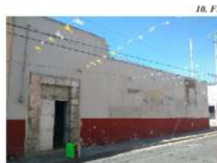
Fachada sobre calle 3 Norte, Fuente: Pedro Martínez Ben, 2017.
