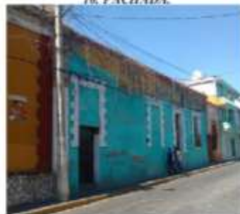
Fachada sobre calle 3 Norte. Fuente: Pedro Martínez Esc. 2017.
