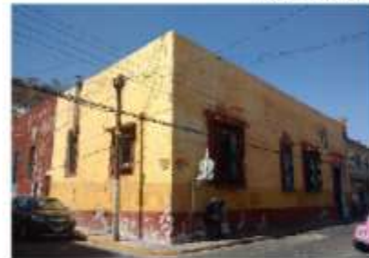
Fachada desde calle 3 Norte y 4 Poniente. Fuente: Pablo Martínez Irujo, 2017.
