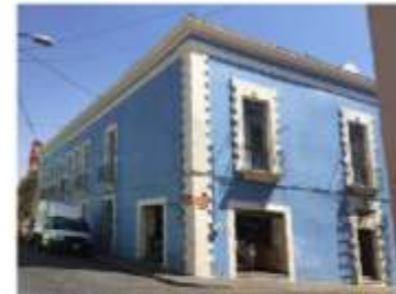
Fachada desde calle 3 Norte y 2 Poniente. Fuente: Pablo Martínez Ibarra, 2017.
