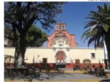
Fachada del conjunto. Fuente: Pedro Martínez Díaz, 2017.
