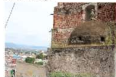
Cúpula en fachada lateral Norte. Fuente: Pedro Martínez Dom, 2017.
