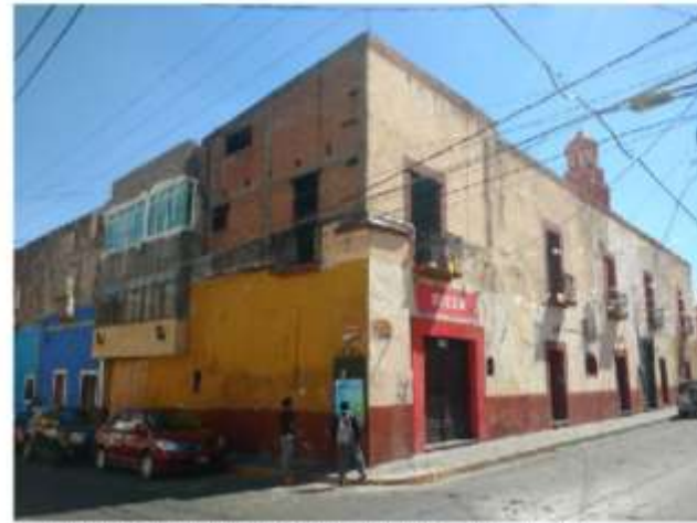
Fachada del inmueble desde esquina 3 Norte y 6 Poniente. Fuente: Pablo Martínez Díaz, 2017.
