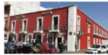
Fachada del inmueble. Fuente: Pablo Martínez Brea, 2017.
