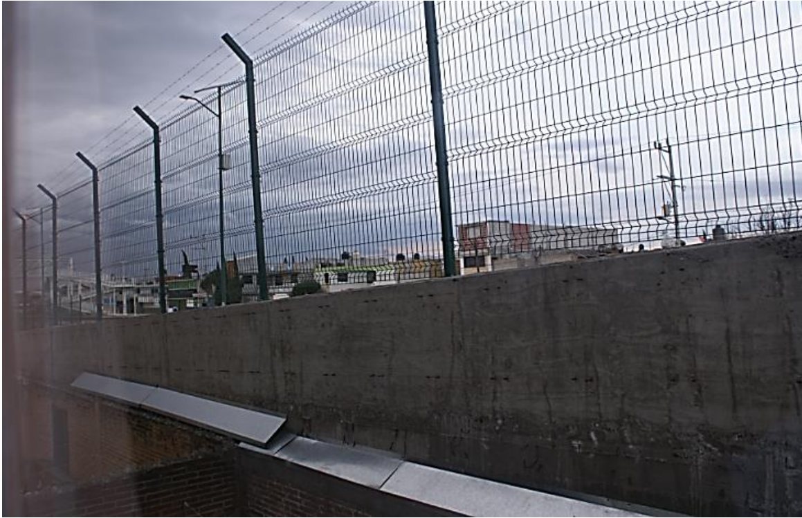
Imagen 17. Parte trasera de la vivienda, la cual está pegada a la vialidad del metrobús
