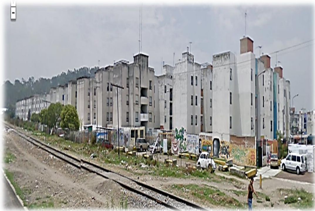
Imagen 5. Vandalismo en la zona en conflicto antes de la construcción del metrobús.
