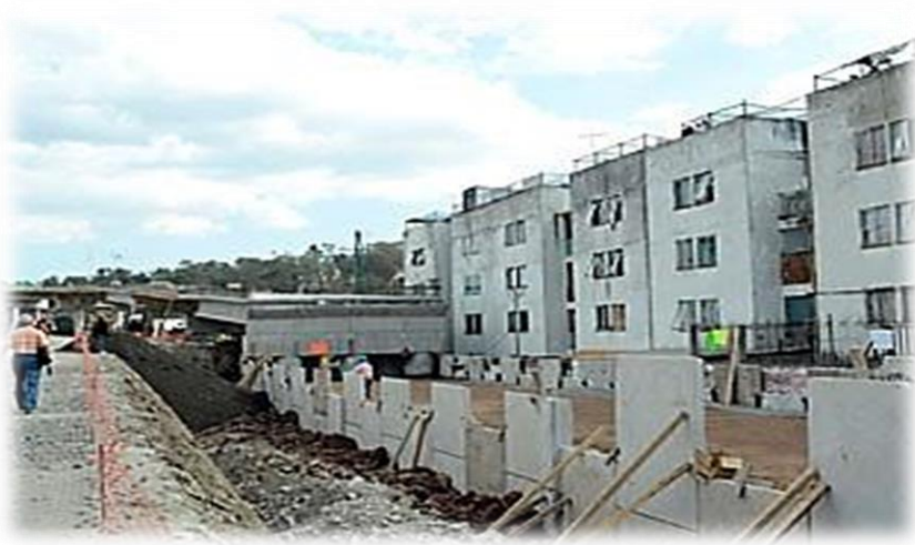
Imagen 8. Construcción para el metrobús
