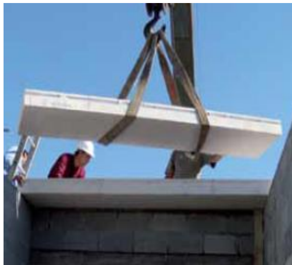
Figura 2.22 Utilización de una grúa o Titán para ayudar a los obreros con poleas sobre los muros de concreto celular
