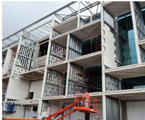
Figura 2.9 Ensamblado de edificio industrial con panel muro de concreto celular
