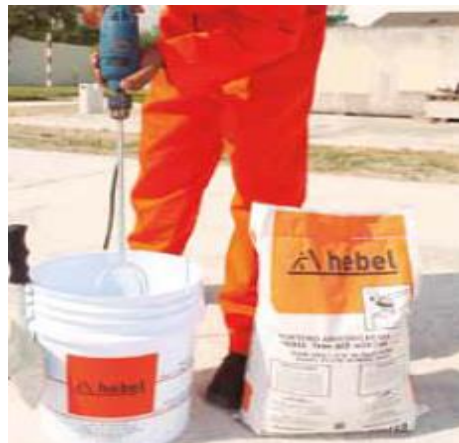
Figura 2.14 Preparación del mortero adhesivo para el pegado del block celular y agregado del aditivo, mezclado con el mortero para las juntas. Fuente Xella Mexicana.
