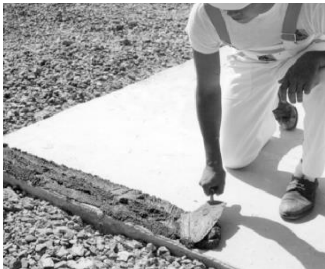
Figura 2.12 Aplicación del mortero para pegar la primera hilada de blocks
