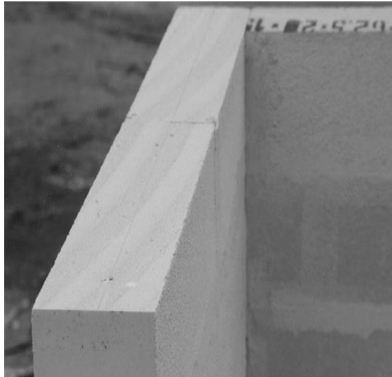
Figura 2.21 Revisión del enrase previo a la colocación del panel losa
