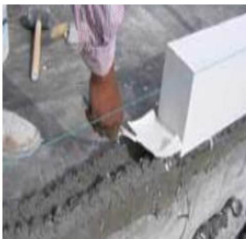
Figura 2.15 Aplicación de la mezcla con la consistencia adecuada.
