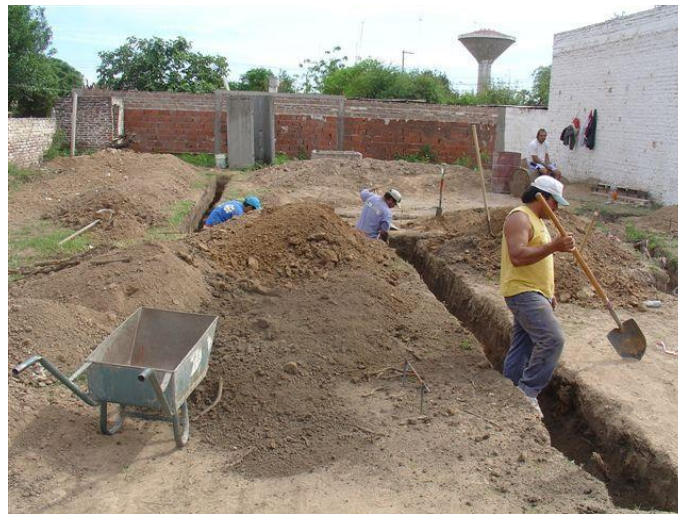
Figura 2.10 Excavación del terreno natural
