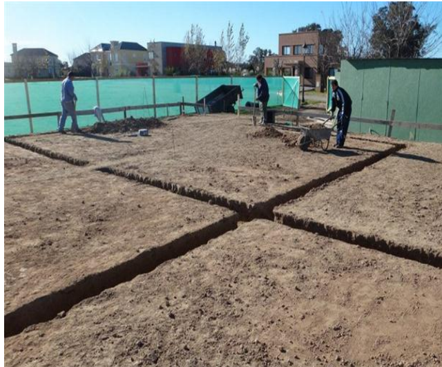
Figura 2.11 Preparación del terreno natural para el armado, cimbrado y colado de la cimentación
