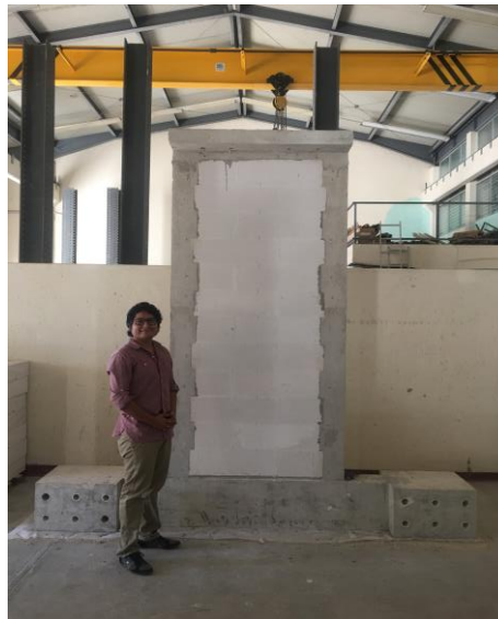
Figura 2.5 Armado y colado de los castillos del muro “ in situ ”, con mampostería de block celular.
