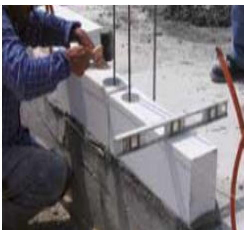
Figura 2.16 Revisión del nivel de cada block, a cada cierta hilada.
