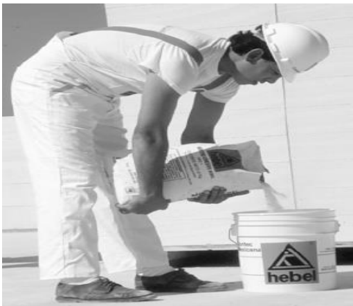
Figura 2.14 Preparación del mortero adhesivo para el pegado del block celular y agregado del aditivo, mezclado con el mortero para las juntas. Fuente Xella Mexicana.
