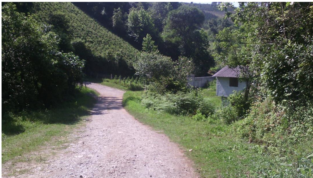
Figura. 6 Camino de terracería en estudio. Elaboración propia.
