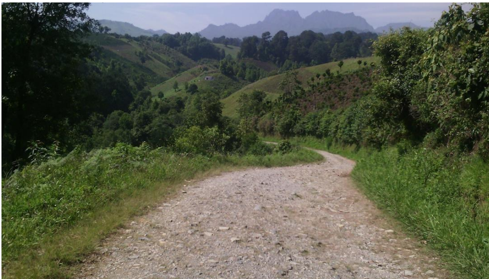
Figura. 4 Camino de terracería en estudio. Elaboración propia.
