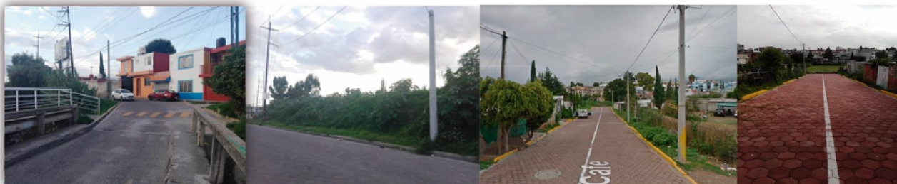
Ilustración 54 Pavimentación con carpeta asfáltica y adoquinado, Xicale K. 2019
