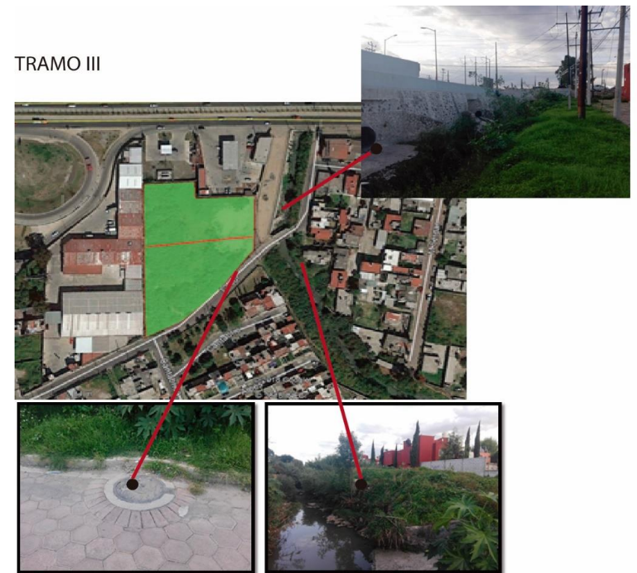
POZO DE VISITA
