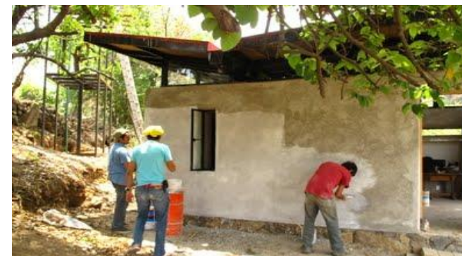
4.2.4.2 Aplicación De Pintura E Impermeabilizante Natural
