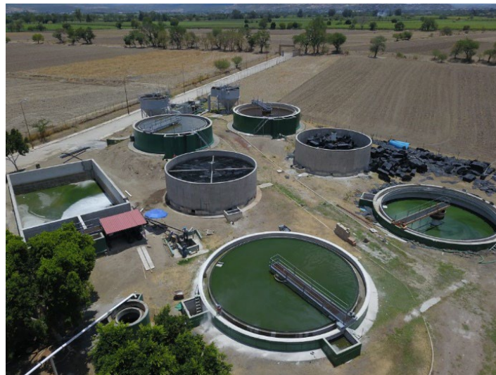
Figura 4.13. PTAR Izúcar de Matamoros al concluir la primera etapa de rehabilitación (Fuente: SOSAPAMIM, 2022, Disponible en: https://www.sosapamim.gob.mx/ )
