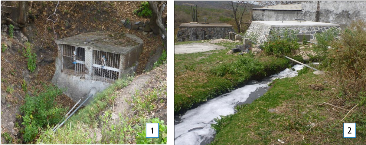
Figura 4. 1. Manantial de Emilio Portes Gil y 2) Almacenamiento de agua potable y paso del agua del Río Atoyac.
