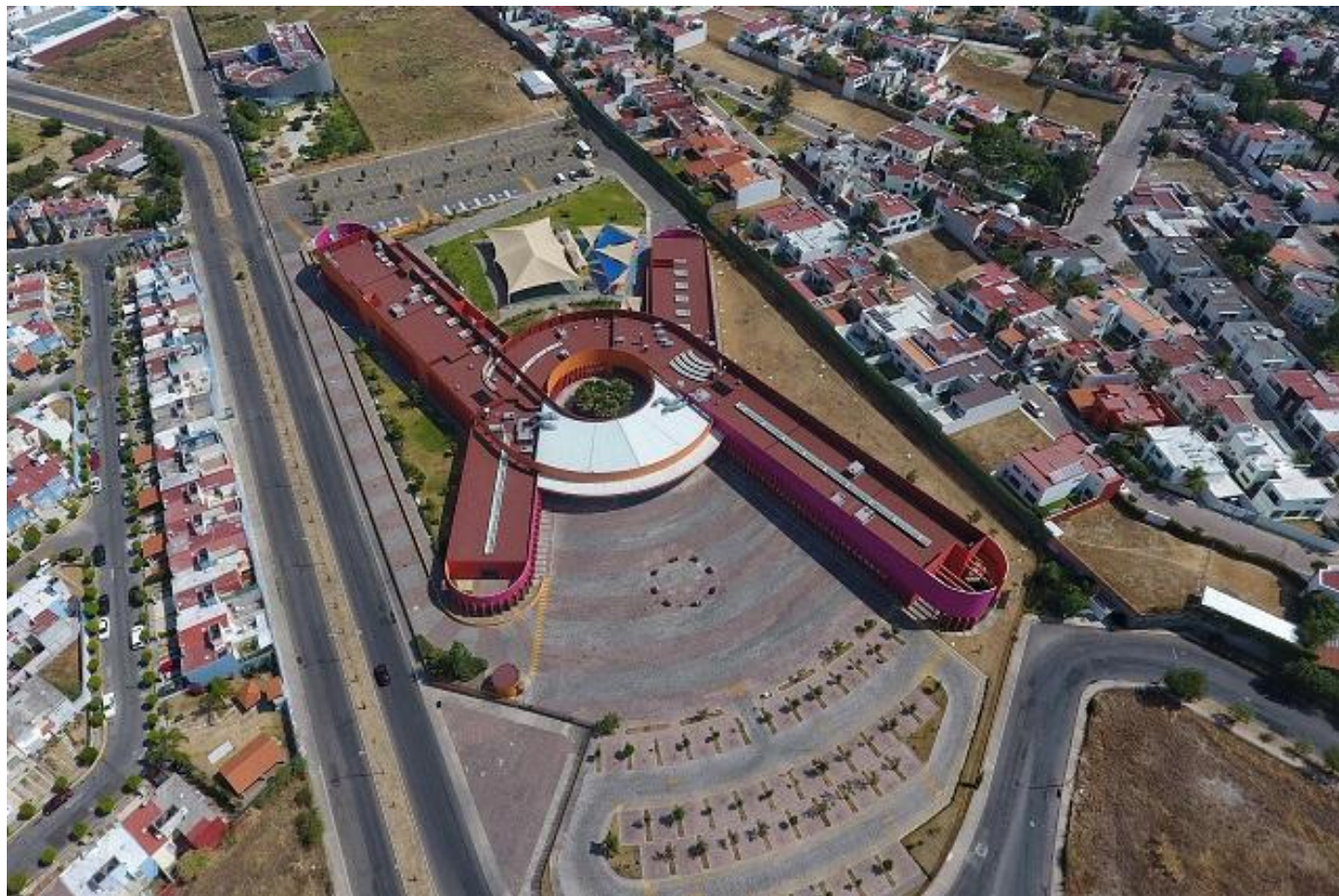
Figura 12. Ruíz, L. (2020). Convierten CRIT Puebla en centro de atención Covid-19 [Fotografía]. Recuperado de https://www.e-consulta.com/nota/2020-05-12/salud/convierten-crit-puebla-en-centro-de-atencion-covid-19
