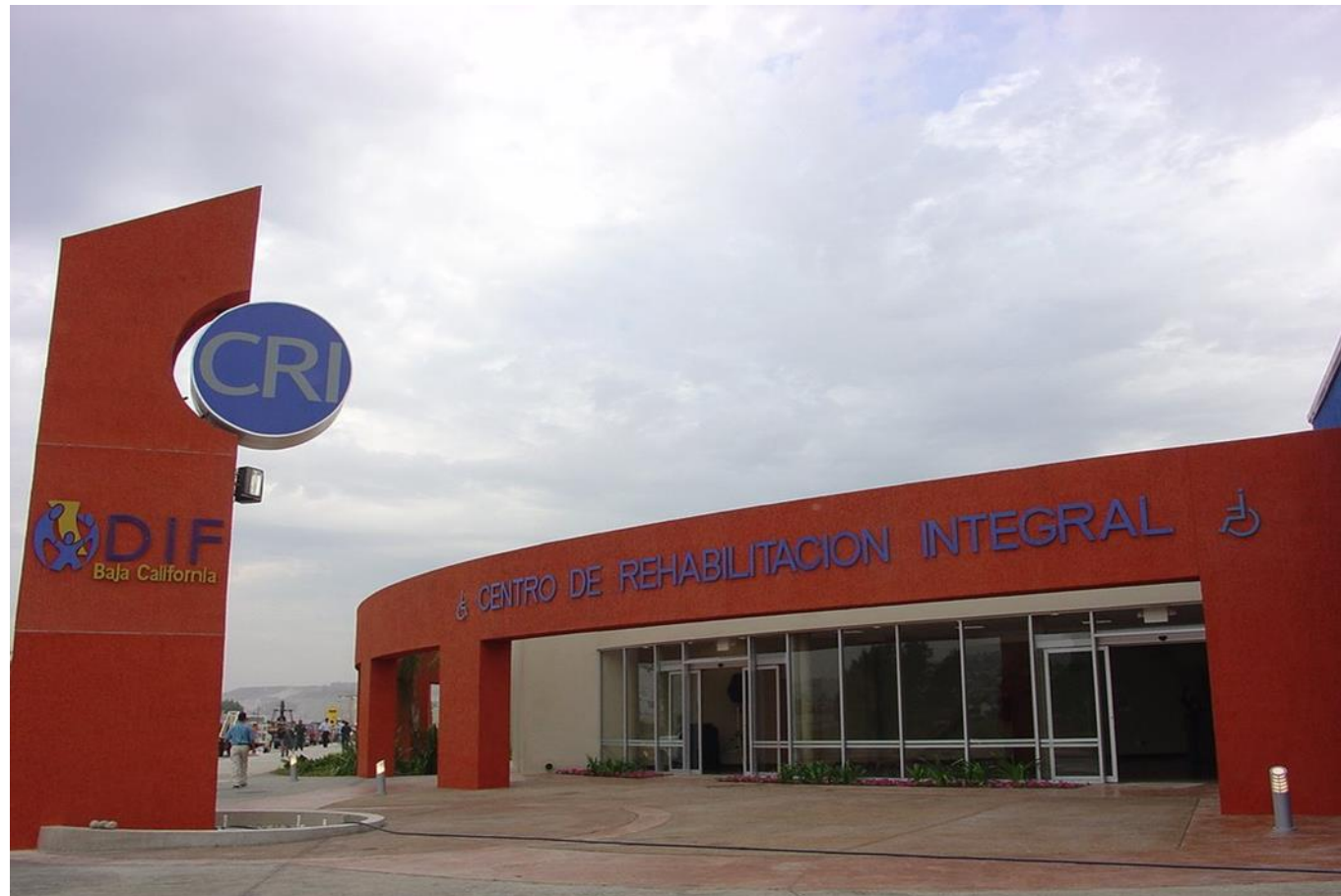
Figura 22. Martínez, M. (2006, agosto). Centro de Rehabilitación de Tijuana Fachada principal del edificio. [Fotografía]. Recuperado de https://www.imcyc.com
