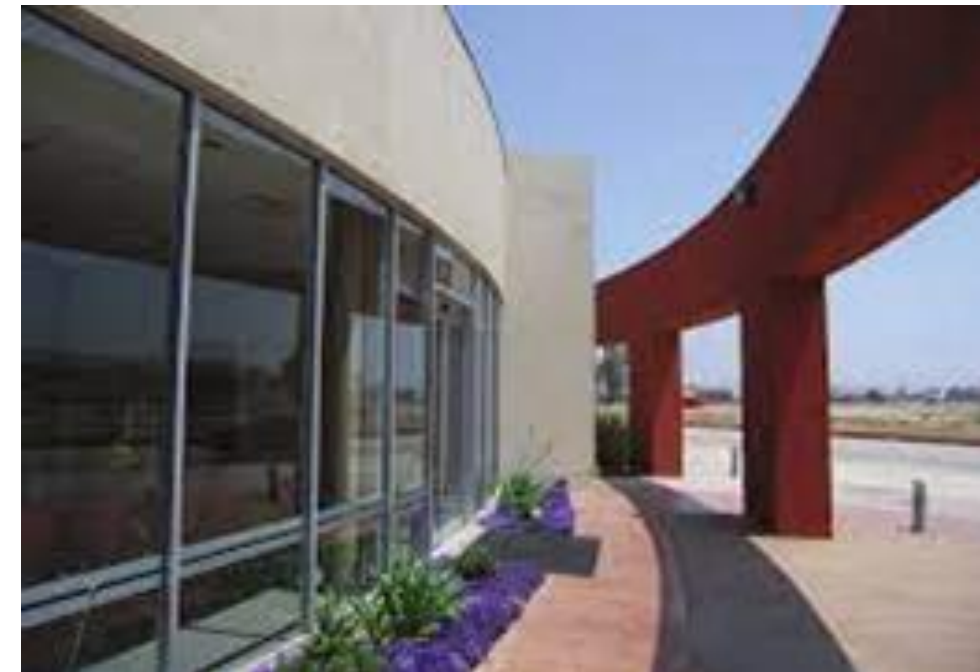
Figura 27. Martínez, M. (2006, agosto). Centro de Rehabilitación de Tijuana Curvatura de la fachada principal del edificio. [Fotografía]. Recuperado de https://www.imcyc.com
