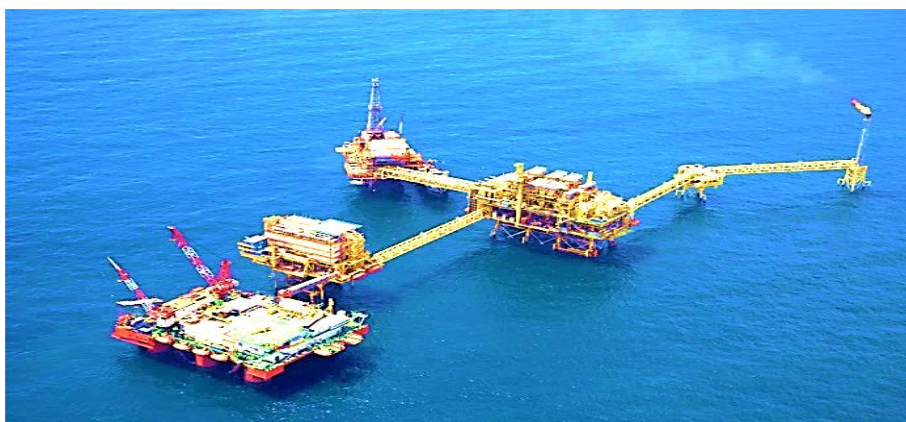
Figura 7. Plataforma de enlace.
