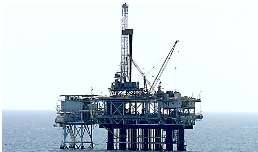
Figura 5. Plataforma de perforación.
