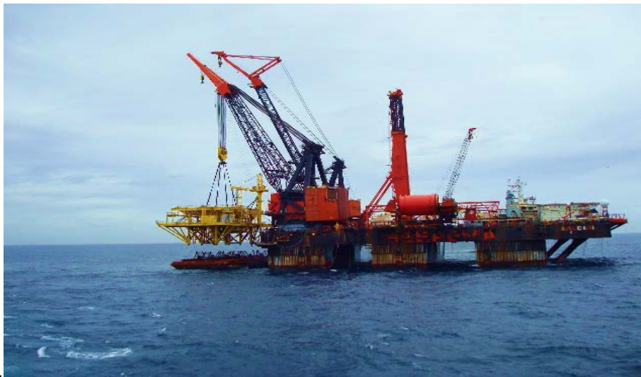
Figura 25. Barco grúa izando una superestructura.
