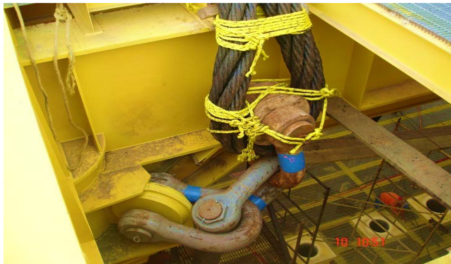
Figura 24. Arreglo de izaje listo para ser estrobado.
