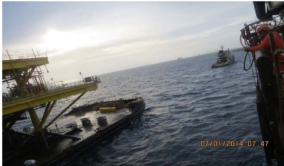
Figura 27. Superestructura colocada en un chalán siendo transportada con ayuda de un remolcador.
