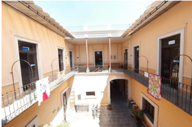
Imagen 24. Vista de la galería norte del patio principal. Toma propia
