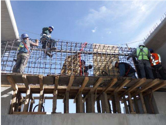
Fotografía 47 y 48. Armado en diafragma y Colado.
