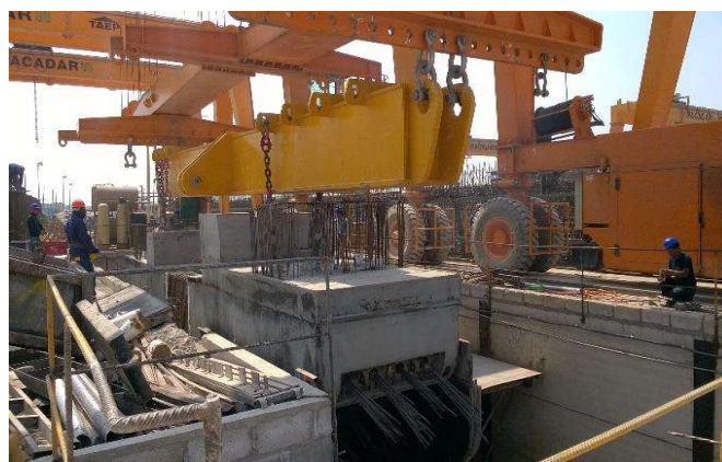
Fotografía 30. Extracción del elemento
