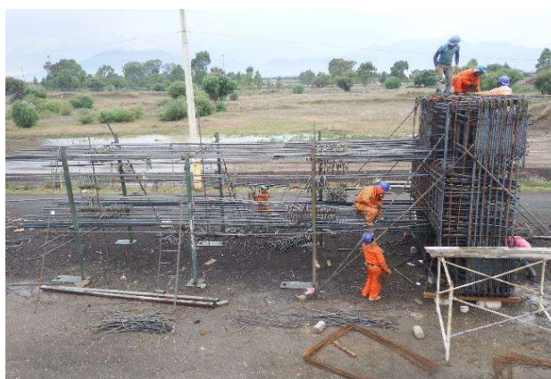
Fotografía 19. Habilitado de Acero de Refuerzo
