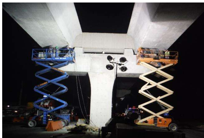
Fotografía 50. Gateo de trabes para retiro de Calzas
