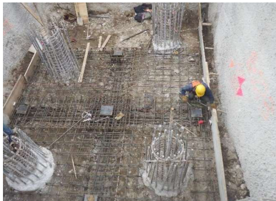
Fotografía 09. Armado de losa de Nivelación
