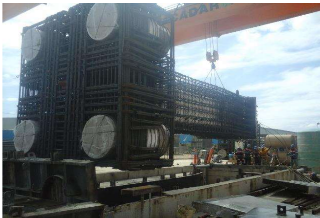
Fotografía 20. Izaje de armado con grúa pórtico para colocación en molde
