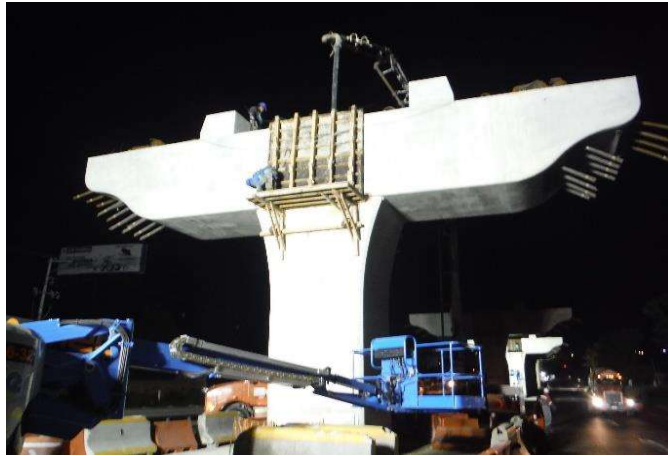
Fotografía 44. Colado de conexión columna - cabezal
