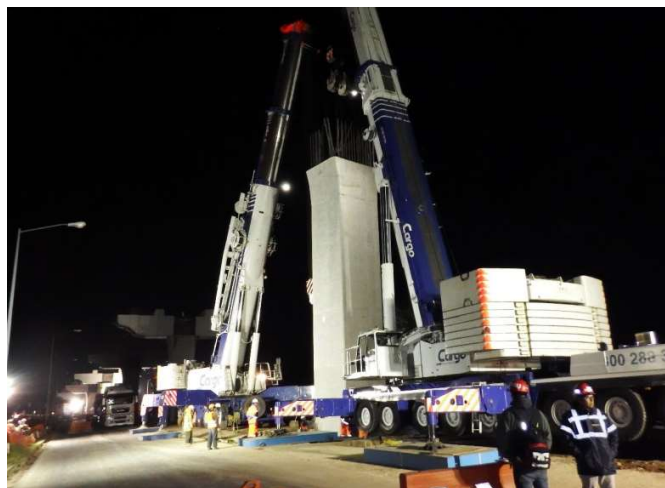
Fotografía 42. Montaje de Zapata – Columna
