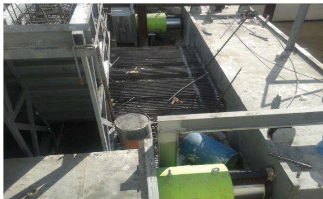
Fotografía 37. Tensado de torones en cama de tensado
