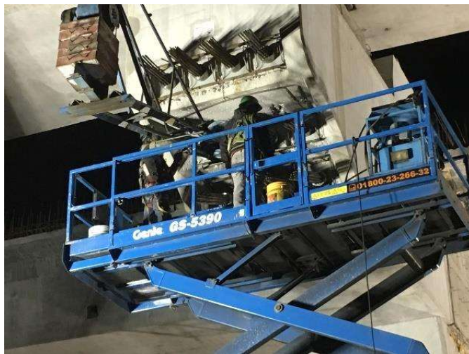
Fotografía 45. Tensado de torones
