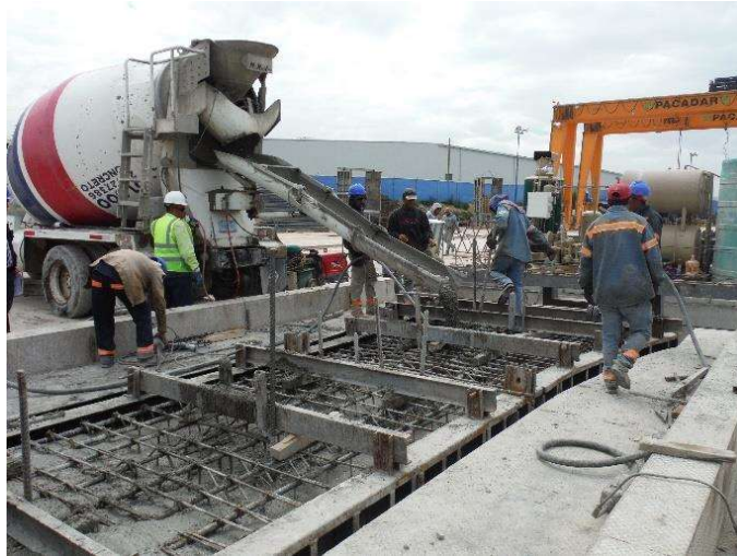
Fotografía 21. Colado del elemento con concreto f'c = 400 \text{ kg/cm}^2 a tiro directo
