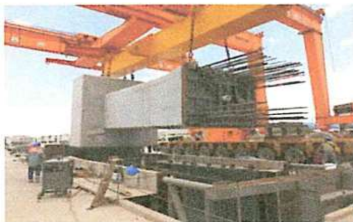
Fotografía 22. Extracción del elemento
