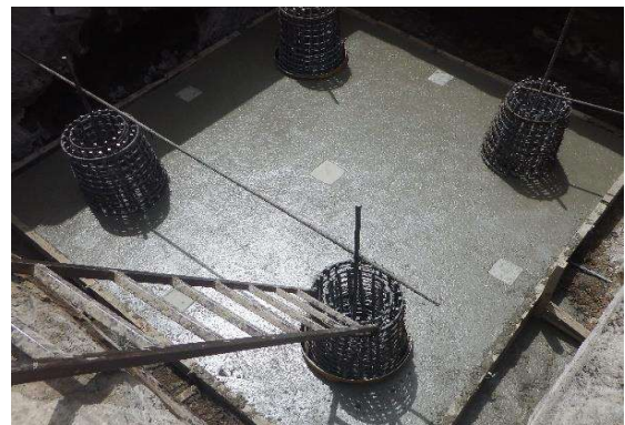
Fotografía 10 y 11. Colado de losa de Nivelación y losa de nivelación terminada
