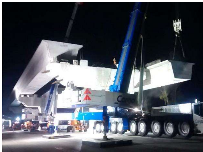
Fotografía 46. Montaje de trabe
