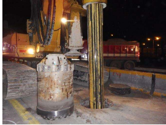
Fotografía 01. Perforación de pila con equipo rotatorio
