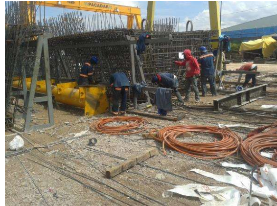
Fotografía 33 y 34. Armado de Acero de refuerzo en trabe y Colocación de acero de presfuerzo
