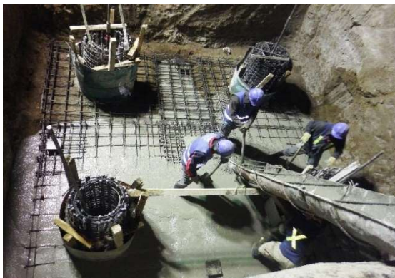
Fotografía 10 y 11. Colado de losa de Nivelación y losa de nivelación terminada
