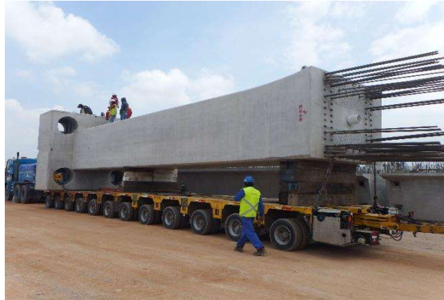
Fotografía 25. Estiba y colocación del elemento en plataforma
