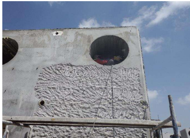
Fotografía 24. Acabado escarificado en base de zapata y huecos de conexión con pila
