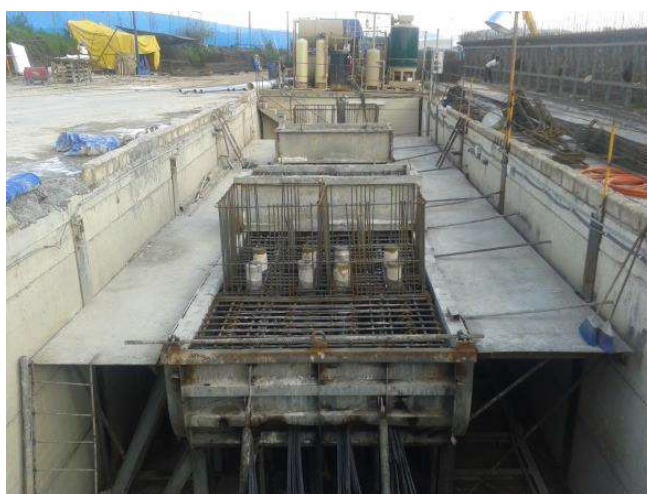
Fotografía 28. Cimbrado de cabezal para colado
