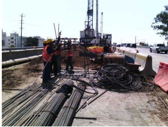
Fotografía 02. Habilitado de Acero de refuerzo en zona confinada
