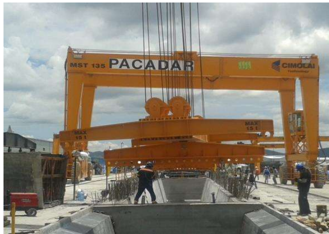
Fotografía 39. Extracción del elemento
