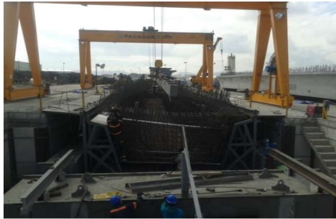
Fotografía 36. Colocación de acero en molde
