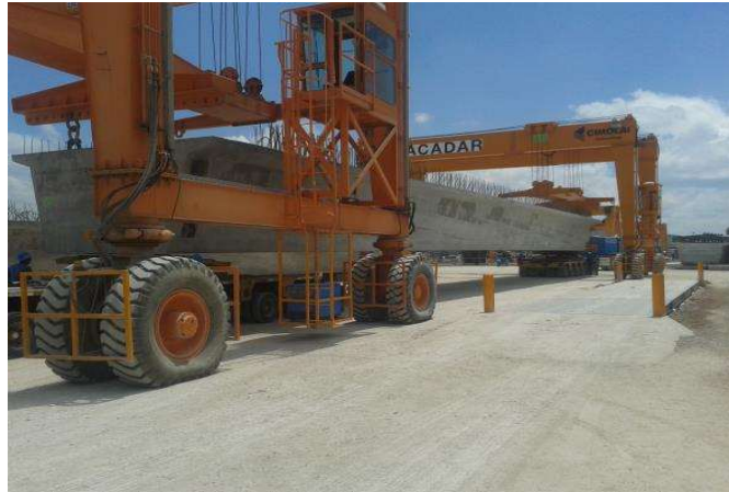
Fotografía 41. Estiba y colocación de elemento en plataforma Dolly
