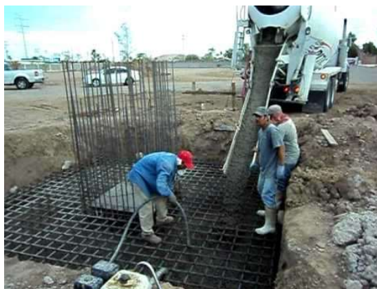
Fotografía 13. Colado de zapata aislada
