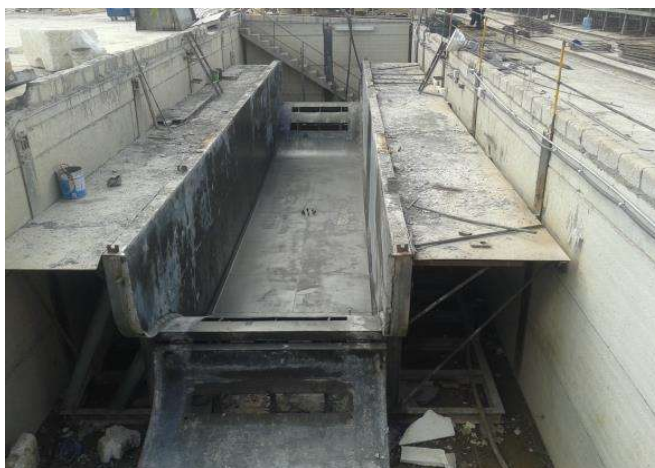
Fotografía 27. Molde para cimbra de cabezal tipo
