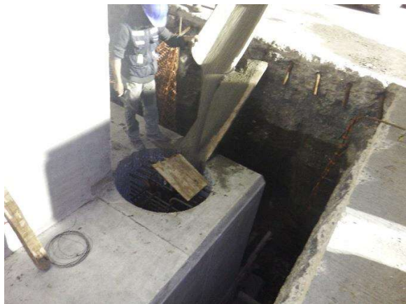
Fotografía 15. Colado de nodo en zona de presfuerzo de pila
