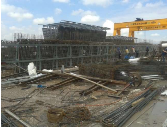
Fotografía 33 y 34. Armado de Acero de refuerzo en trabe y Colocación de acero de presfuerzo
