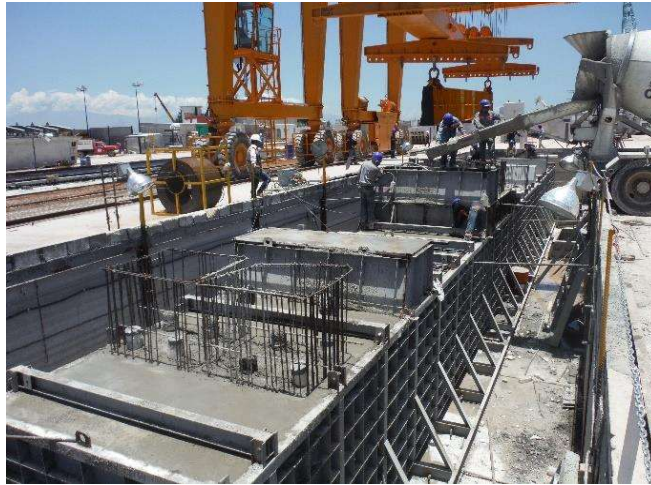
Fotografía 29. Colado de cabezal a tiro directo
