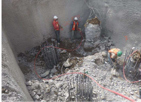
Fotografía 07. Descabece de pilas con Martillo Neumático
