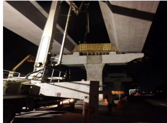
Fotografía 47 y 48. Armado en diafragma y Colado.
