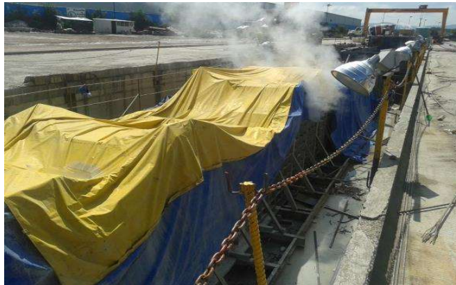
Fotografía 31. Aplicación de vapor mediante cámara de curado
