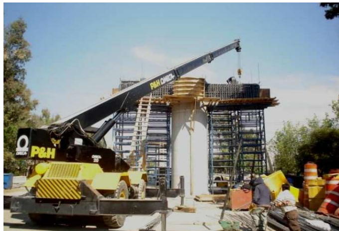
Fotografía 16. Colocación de cimbra con apoyo de grúa
