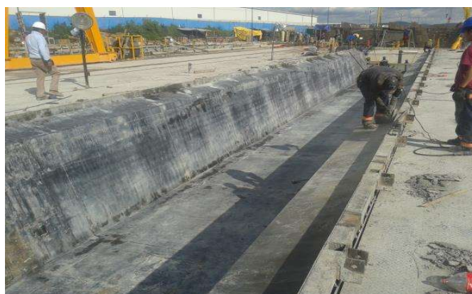
Fotografía 35. Preparación de molde para trabe
