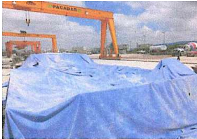
Fotografía 23. Aplicación de vapor mediante cámara de curado
