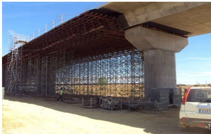
Fotografía 17. Cimbrado para desplante de trabe
