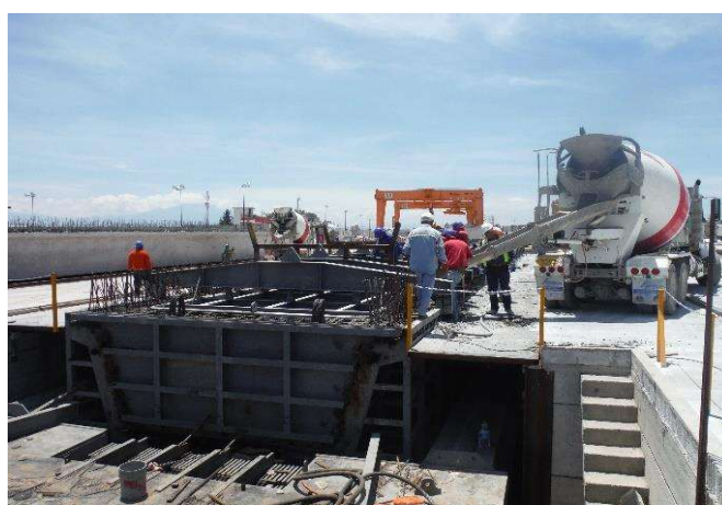
Fotografía 38. Colado de trabe a tiro directo
