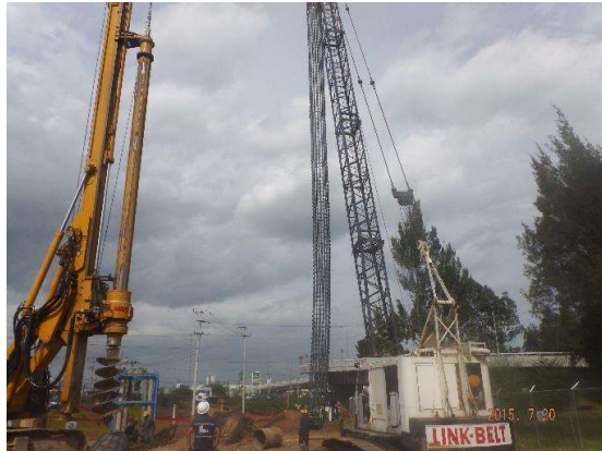
Fotografía 03. Izaje y colocación de Armado de pila en excavación
