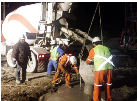
Fotografía 05. Colado de pila con Tubería Tremie
