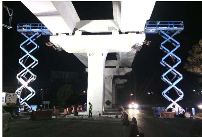
Fotografía 49. Tensado de Torones en diafragma
