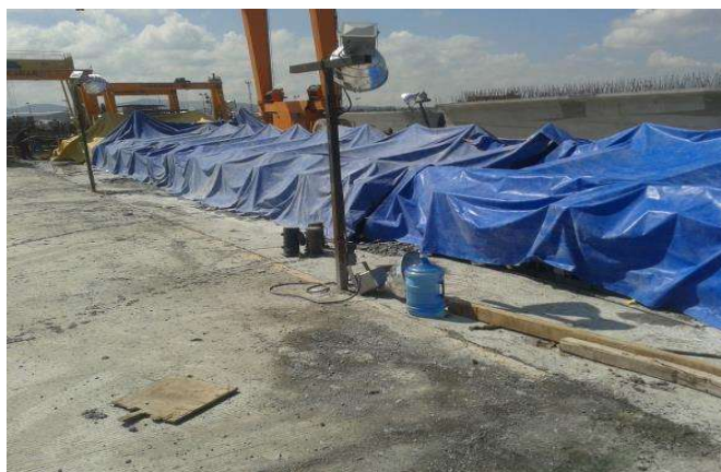
Fotografía 40. Aplicación de vapor mediante cámara de curado
