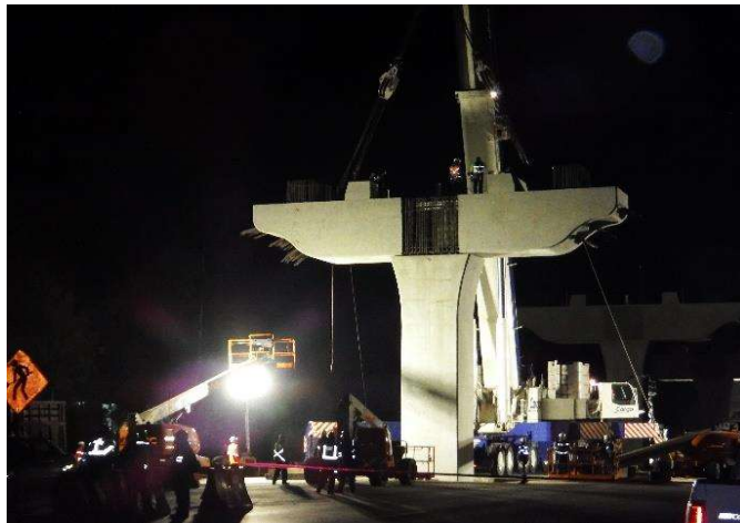
Fotografía 43. Montaje de cabezal
