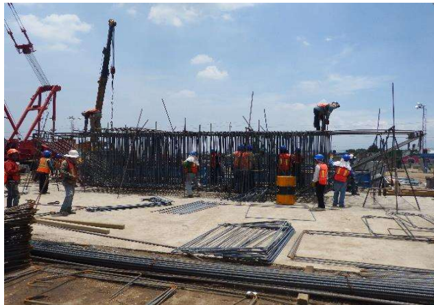
Fotografía 26. Armado del acero de refuerzo en cabezal
