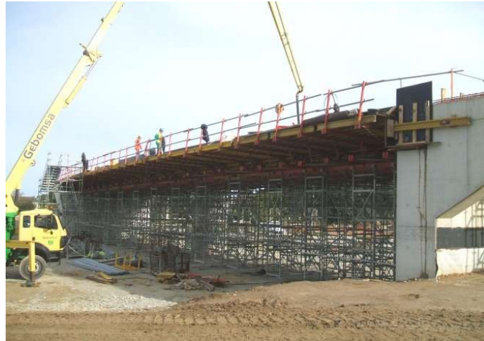
Fotografía 18. Colado de trabe
