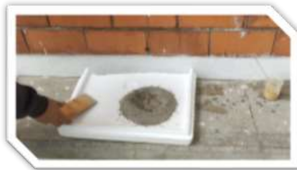
Ilustración 9. Preparación del adoquín piloto
