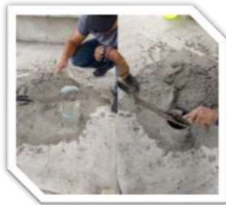
Ilustración 14. Vaciado de la mezcla en los moldes
