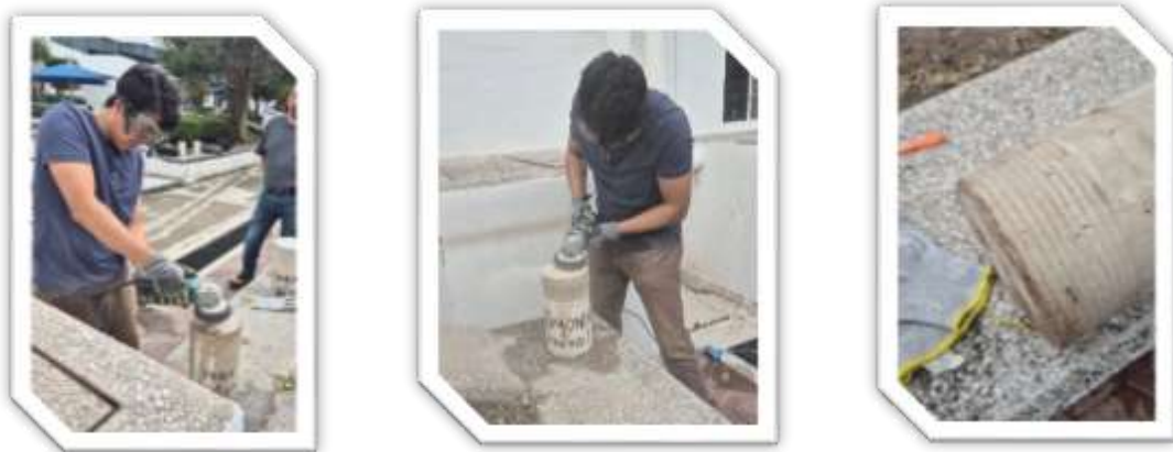
Ilustración 19. Desbaste y pulido de probetas de concreto
