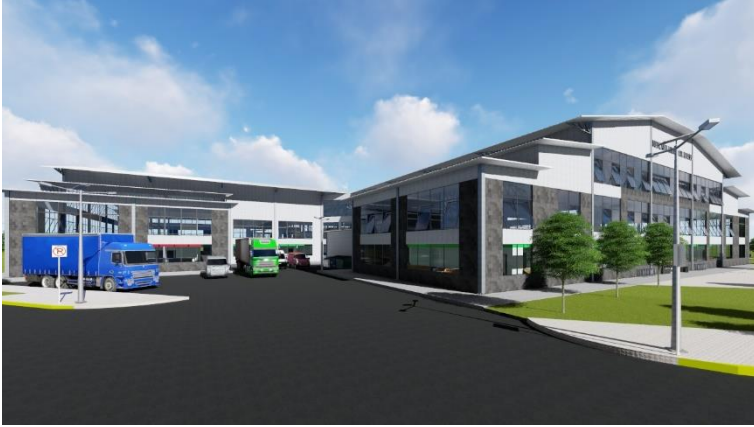
AREA DE DESCARGA
