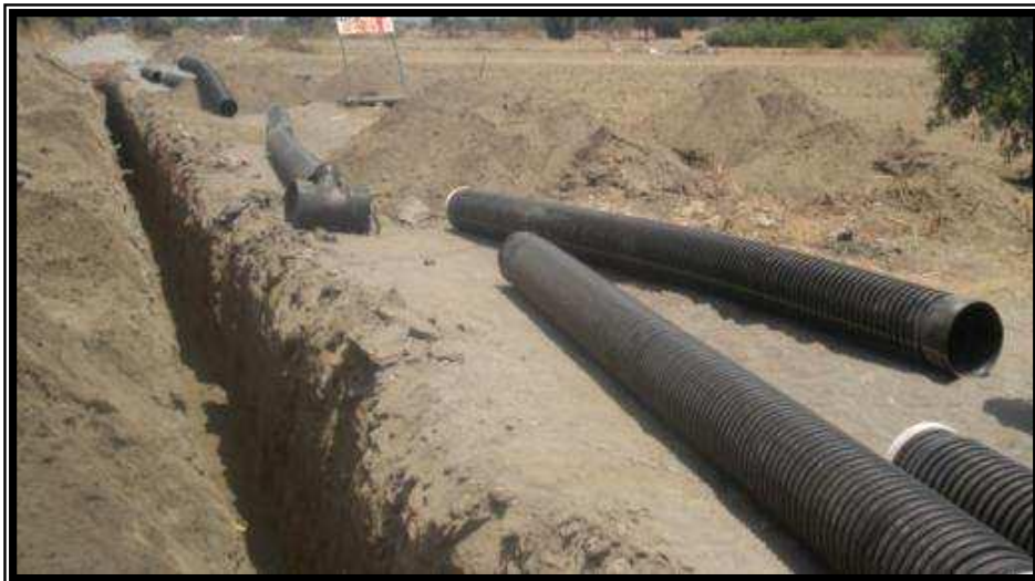
Figura 2.4.2 Se recomienda que se tengan los tubos a un lado de la zanja.
