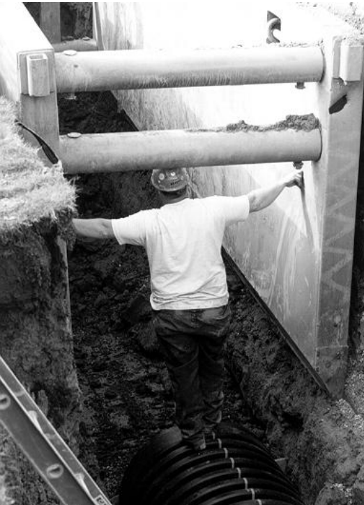
Figura 4.1. Apuntalamiento mediante una caja de trinchera.
