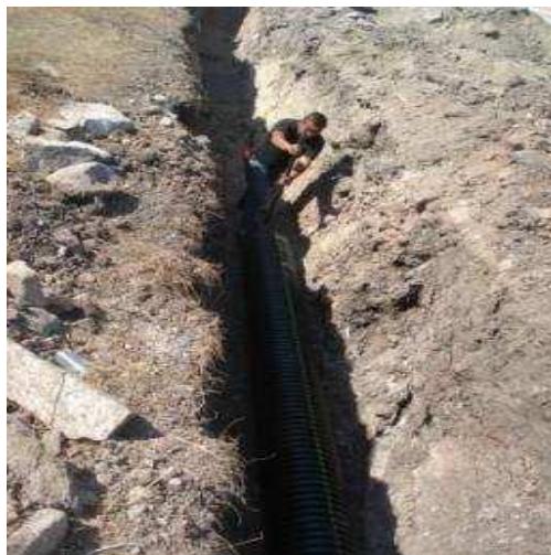
Figura 3.3.2 El acople mediante barreta.
