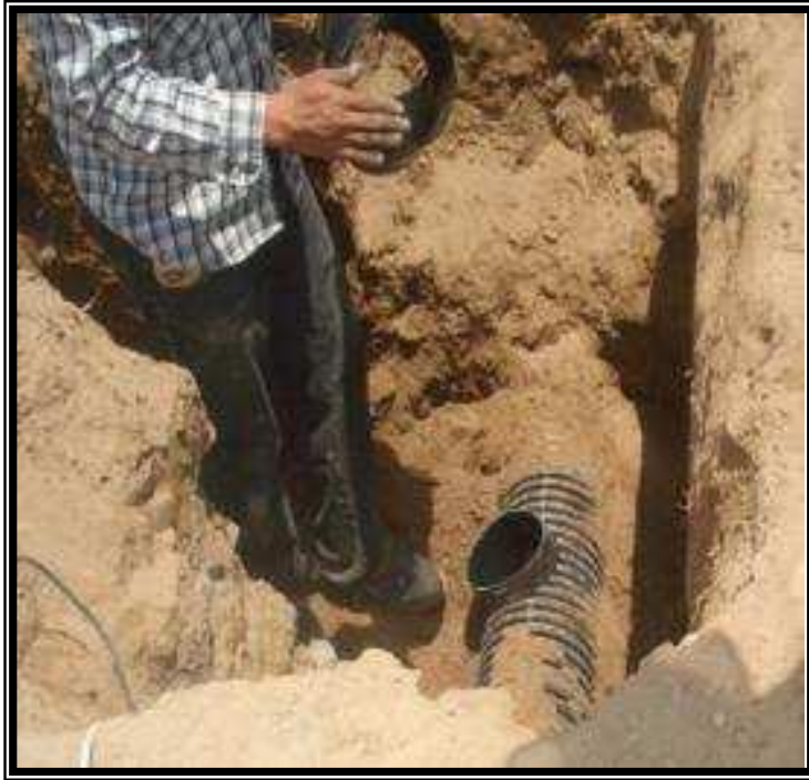
Figura 3.6.5 Lubrique la parte interna del empaque y la espiga.
