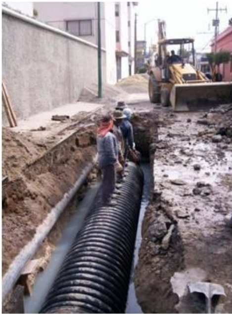
Figura 4.2. La tubería ADS N-12 flota en la presencia de de agua.
