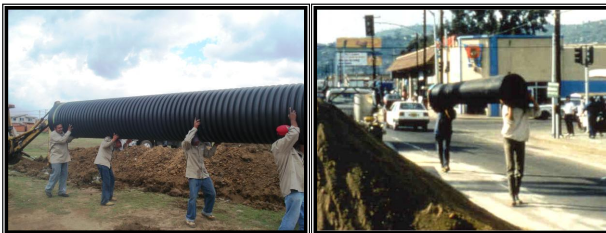
Figura 2.3 Los tubos pueden descargarse fácilmente a mano por su ligereza.
