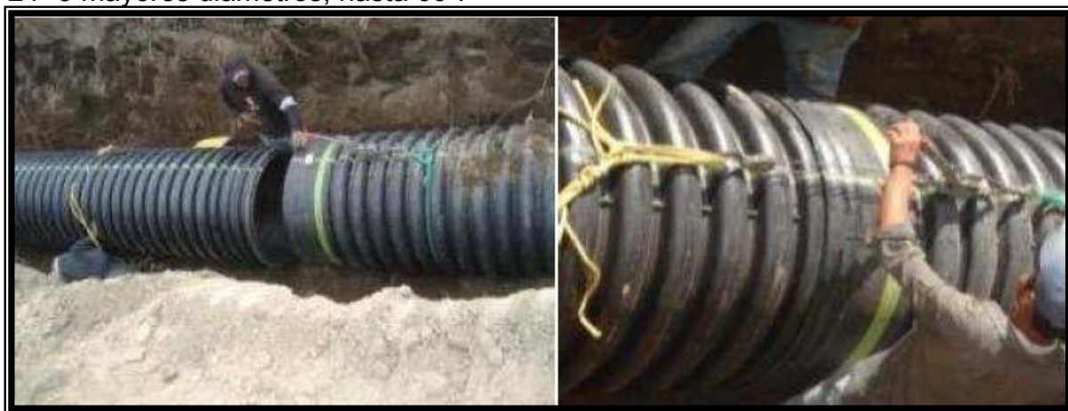
Figura 3.3.4. El acople mediante tirfo.
