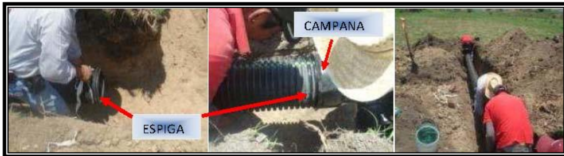
Figura 3.3.1. El acople manualmente.
