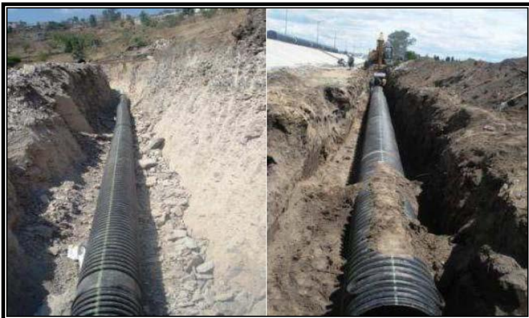
Figura 3.2.2 la línea verde del tubo debe quedar en la parte superior para tener una referencia en su alineación
