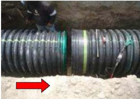
Figura 3.2.3. El acople debe hacerse de espiga a campana.
