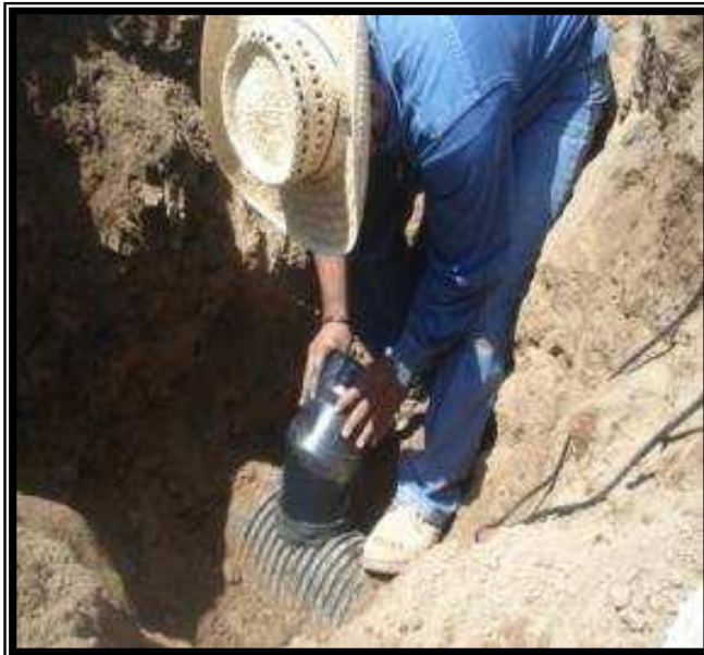
Figura 3.6.6 Instale la inserción.
