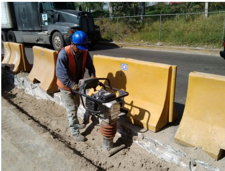
Figura 2.5.3 Compactación del material para plantilla con bailarina
