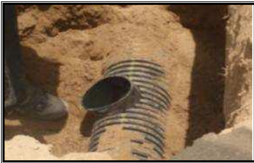
Figura 3.6.4 Inserte en la perforación el empaque
