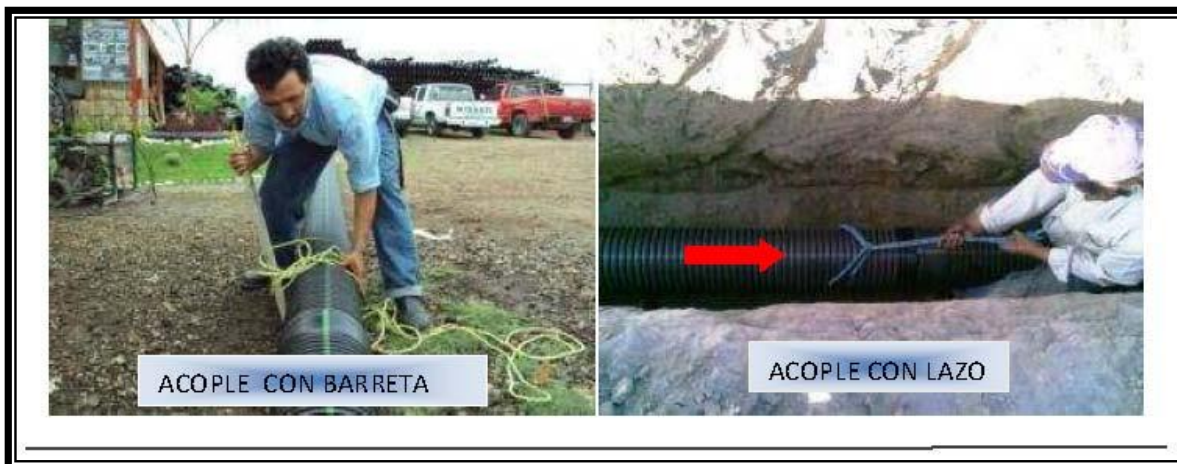
Figura 3.3.3. El acople mediante barreta y/o lazo.
