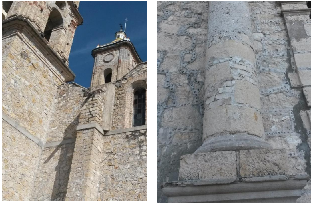
Imagen No. 77 Muros de piedra aparente, juntas con rajueleado, y cadena de concreto armado en el muro
