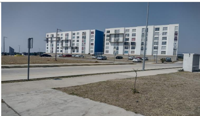
Zona habitacional El Pilar
