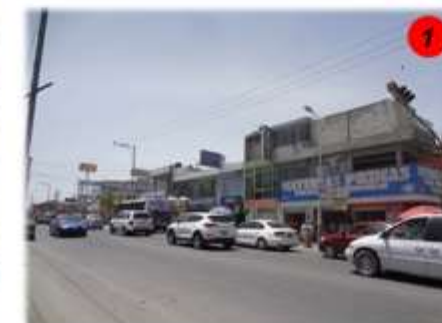
Imagen 2. Serie de locales comerciales y vivienda ubicados en lo que anteriormente era el atrio del exconvento.
