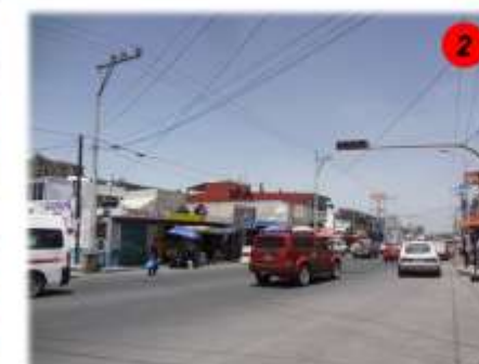
Imagen 3. Serie de locales comerciales ubicados en lo que anteriormente era el atrio del exconvento.
