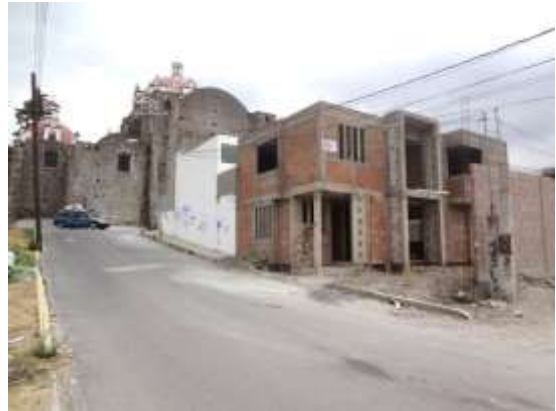
Figura 94. Construcción de fraccionamiento entre las calles 5 poniente y 3 sur. Foto: Omar F.S. (30-03-18).
