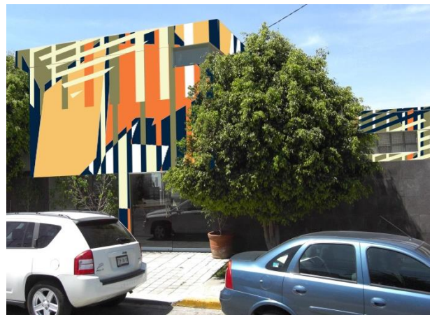
Imagen 23 y 24. Remodelación 2008. Acceso principal.
