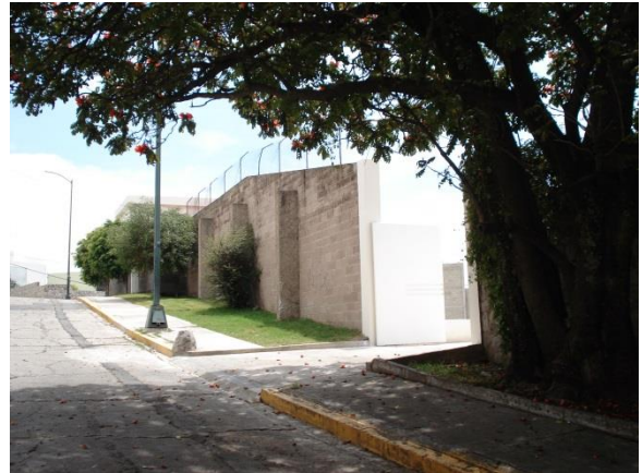
Imagen 12 y 13. Remodelación 2006. Acceso principal.
