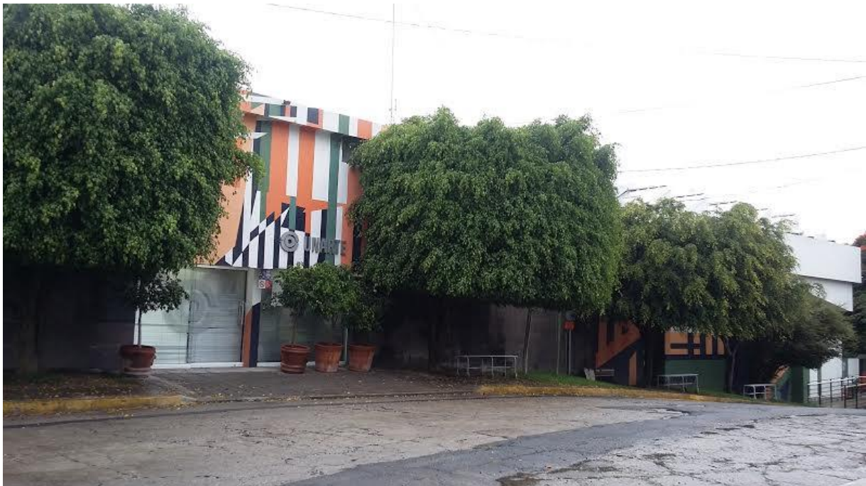
Fachada principal, Acceso calle Matamoros
