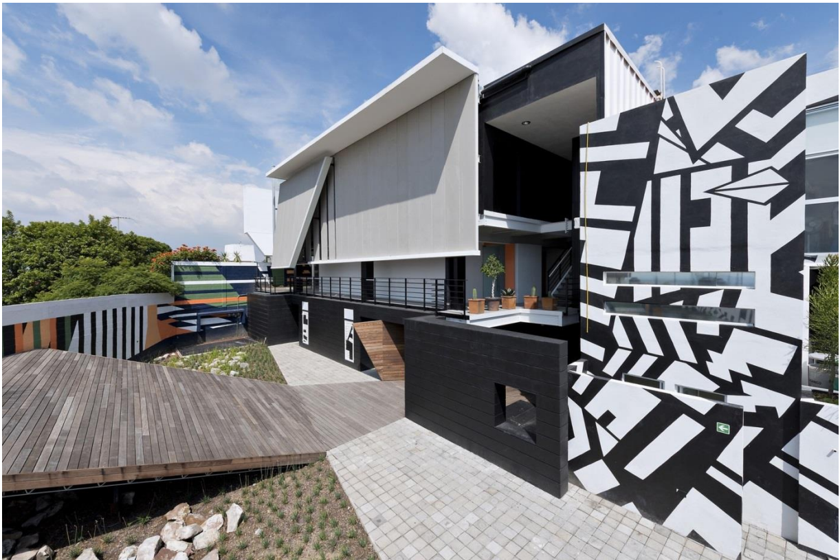
Imagen 34. Edificio LEED 2012. Vista general desde plazuela.
