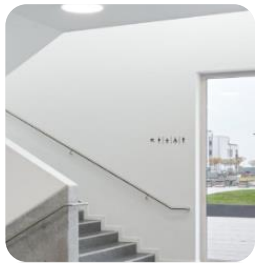
Paredes cubiertas de yeso
