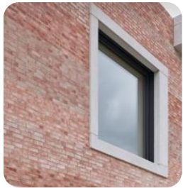
Ventanas con marco de concreto
