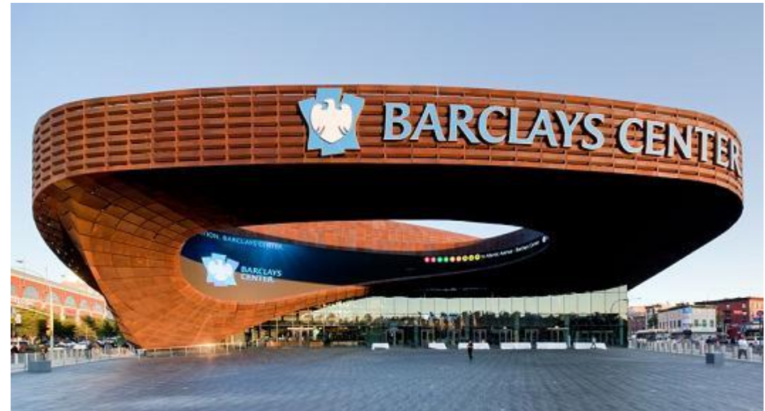
IMAGEN 1 Autor: AEMoreira042281 Creado el: 8 de octubre de 2012, Título de trabajo: Barclays Center western side.jpg. Recuperado de https://encrypted-tbn0.gstatic.com/images?q=tbn:ANd9GcS1L4pL2YyNcFDbZdj2TYIc6yjnkg3ZsYhpljR5DmoJkPo2uU
