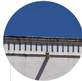
FT.3 MANCHAS DE SUCIEDAD Y ESCURRIMIENTO DE AGUA PLUVIAL EN PARTE SUPERIOR DE PARAMENTO Y COLONIZACIÓN BIOLÓGICA EN CORNISA
