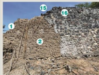
Fotografía 2. Vista de sección 2 (eje A entre ejes 5' y 7), el paramento conformado de muro de adobe presenta desplome y derrumbe de la parte superior, la sección de muro de mampostería de piedra bola presenta una integración de mampostería de piedra volcánica.
