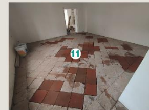
Fotografía 6. Alteración del piso, se sustituyeron las piezas rotas de barro cocido por el mismo material.
