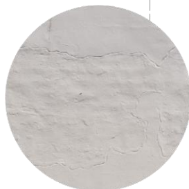
FT.6 INTEGRACIÓN DE APLANADO DE MORTERO CAL-ARENA EN ZONA MEDIA DE PARAMENTO
