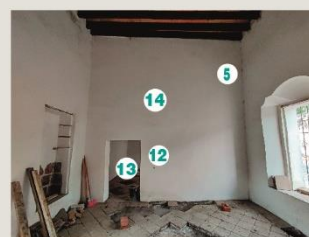
Fotografía 3. Vista de eje B entre ejes 1-2 (sección 2), el muro presenta suciedad en acabado superficial, humedad por capilaridad; la cubierta presenta deformación de vigas de madera, el piso está siendo alterado con sustitución de piezas de barro.
