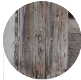
FT.4 CAMBIO DE COLORACIÓN Y ENVEJECIMIENTO DE MADERA POR INTEMPERISMO Y FALTA DE MANTENIMIENTO EN PUERTA DE LOCAL 12 (PÓRTICO)
