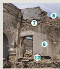
Fotografía 3. Paramento exterior de Sección 3 (eje B entre ejes 3-3') presenta reconstrucción del muro medianero utilizando diferentes tipos de rocas y mortero de cemento-arena, así como la colocación de malla electrosoldada.
