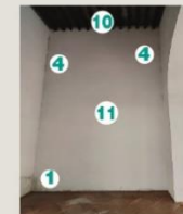
Fotografía 6. Vista de sección 6, alterado con nuevo aplanado y pintura, presenta suciedad en las esquinas superiores de muro y humedad capilar en la zona inferior.
