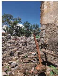
Imagen 1. Interscción de muro medianero y muro del eje 4 de local 7.
