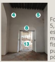
Fotografía 4. Arco de medio punto (sección 4) presenta fisuras en contraclaves, fue alterado con aplanados y pintura recientes.
