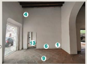
Fotografía 7. Sección 7 presenta manchas por humedad por filtración en esquina superior de muro y suciedad en parte baja de muro.
