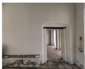
Imagen 2. Vista de muro lateral derecho de local 2.
