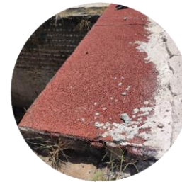
FT.4 DESCAMACIÓN DE LECHADA EN ENTORTADO DE CONCRETO POR MALA COLOCACIÓN Y CAMBIOS DE TEMPERATURA EN LOSA DE PÓRTICO
