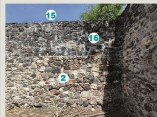
Fotografía 5. Muros de sección 3 (eje B entre ejes 5' y 7) y sección 4 (eje 7 entre ejes A-B). Reconstrucción de la parte superior del muro con un tipo de piedra distinto al resto del muro.
