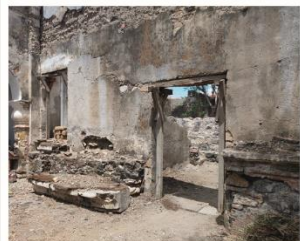
Imagen 2. Vista al acceso del local 7 visto desde el patio.
