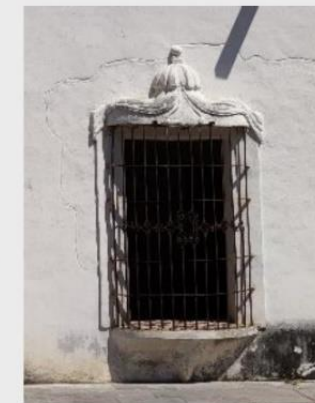
Ventana con balcón bajo, conocido como Cierro en fachada principal de Casa Palestina
