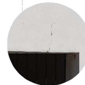
FT.10 GRIETA VERTICAL ASCENDENTE POR ACTIVIDAD SISMICA EN CERRAMIENTO DE VANO
