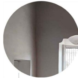
FT.7 DEFORMACIÓN DE MURO EN PARTE SUPERIOR Y PÉRDIDA DE VERTICALIDAD POR FALLA CONSTRUCTIVA DE MURO DE LOCAL 4
