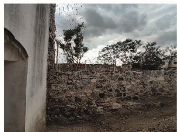
Imagen 2. Local 6, vista del muro poniente hacia la colindancia.
