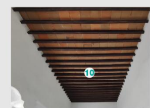
Fotografía 10. Integración de losa catalana y salidas eléctricas para iluminación.
