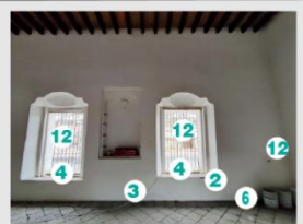
Fotografía 2. Muro (sección 1) alterado con aplanados y pintura recientes. Presenta humedad capilar en la parte baja del muro y pérdida de pintura.
