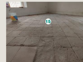
Fotografía 7. Piso después de la colocación de piezas nuevas de barro cocido, cepilladas con una mezcla de tierra y cal para unificar el color de todas las piezas.
