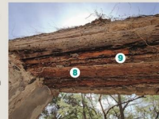
Fotografía 7. Deterioro en madera del dintel en vano de la sección 3 (eje B entre ejes 5' y 7). Presenta cambio de coloración, fendas y envejecimiento ocasionado por agentes físicos y biológicos.
