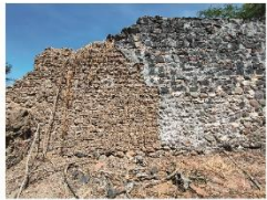
Imagen 1. Muro medianero en local 9.
