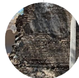
FT.10 DESPRENDIMIENTO DE APLANADOS POR INTEMPERISMO EN ZONA INFERIOR DE MURO DE LOCAL 8
