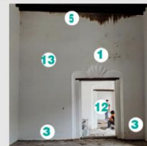
Fotografía 2. Muro (sección 1) alterado con aplanados y pintura recientes. Presenta humedad capilar en la parte baja del muro y pérdida de pintura.
