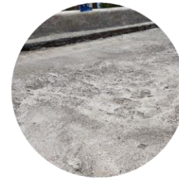
FT.4 DESCAMACIÓN DE LECHADA EN ENTORTADO DE CONCRETO POR MALA COLOCACIÓN Y CAMBIOS DE TEMPERATURA EN LOSA DE PÓRTICO
