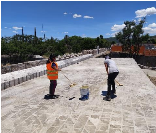
Impermeabilización de cubierta de crujía sur
