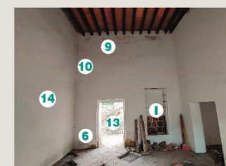
Fotografía 3. Vista de eje B entre ejes 1-2 (sección 2), el muro presenta suciedad en acabado superficial, humedad por capilaridad; la cubierta presenta deformación de vigas de madera, el piso está siendo alterado con sustitución de piezas de barro.
