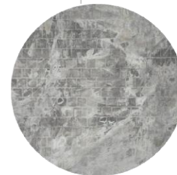
FT.9 MANCHAS POR DESLAVADO DE IMPERMEABILIZANTE DE ALUMBRE Y JABÓN EN CUBIERTA DE CRUJIA SUR
