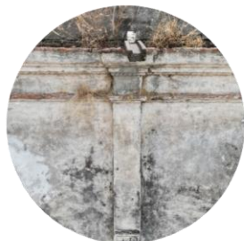
FT.2 MANCHAS POR HUMEDAD POR FILTRACIÓN DE AGUA Y PÉRDIDA DE PINTURA EN ELEMENTOS ORNAMENTALES DEL PÓRTICO
