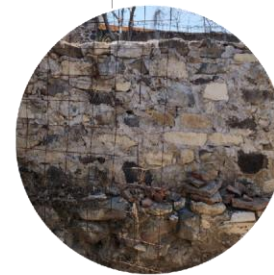
FT.9 RECONSTRUCCIÓN DE SECCIÓN DE MURO MEDIANERO CON NUEVOS MATERIALES EN LOCAL 6
