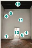
Fotografía 6. Vista de sección 6, alterado con nuevo aplanado y pintura, presenta suciedad en las esquinas superiores de muro y humedad capilar en la zona inferior.
