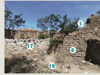
Fotografía 3. Vista de sección 2 (eje A entre ejes 4-5') presenta reconstrucción de muro faltante con nuevos materiales (muro de adobe completado con mampostería de piedra bola).
