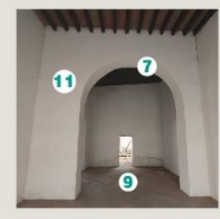
Fotografía 4. Arco de medio punto (sección 4) presenta fisuras en contraclaves, fue alterado con aplanados y pintura recientes.
