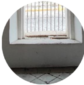
FT.5 MANCHAS DE SUCIEDAD Y POR HUMEDAD POR CAPILARIDAD EN ANTEPECHO DE VANO IZQUIERDO DEL LOCAL 3
