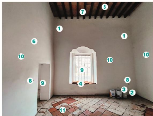
Fotografía 1. Local 4 en crujía sur de Casa Palestina.
