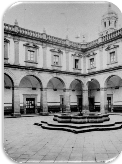
Img. 9 Edificio Carolino 1er patio . Fuente: AHU de la BUAP, Fondo “Lara y Parra”
