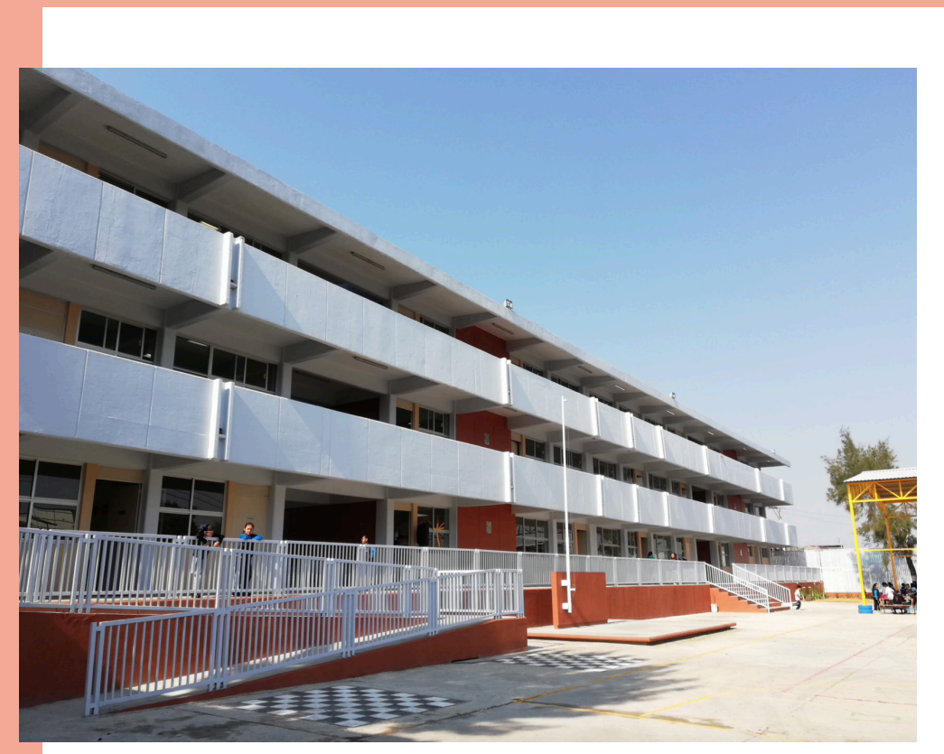
Imagen 19. Esc. Primaria "Ricardo García Zamudio" reconstruida en su totalidad después del sismo de 2017. Iztapalapa. CDMX. Mayo 2019.
