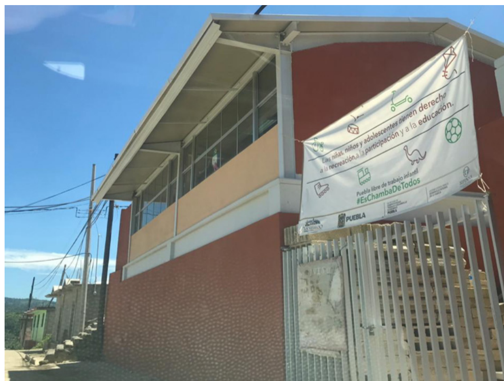
Imagen 26. Fachada actual de la escuela primaria Xicotencatl. Yamile Salib. Agosto 2019.
