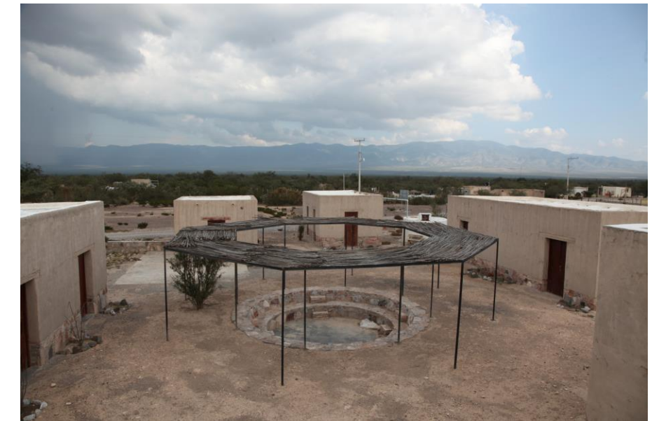
Figura 18. Vista elevada del Centro Comunitario las Margaritas.
