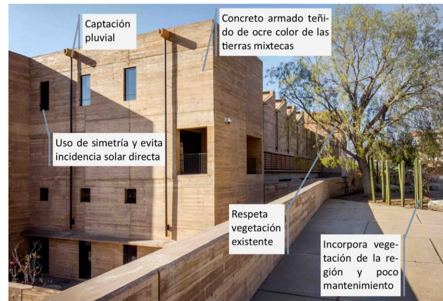
Figura 26. Vista exterior del Edificio del Archivo Histórico del Estado de Oaxaca. Fuente: Imagen recuperada de https://www.archdaily.mx/mx/868853/edificio-del-archivo-historico-del-estado-de-oaxaca-mendaro-arquitectos (2021).
