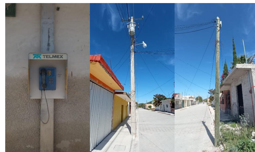
Figura 70. Medel, E. (2021). Fotografías de infraestructura en San Felipe Otlaltepec.
