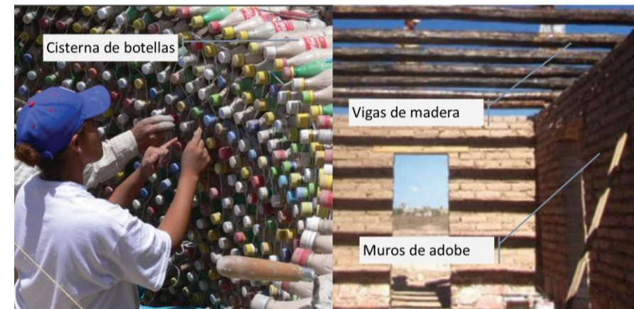
Figura 21. Técnicas de construcción del Centro Comunitario las Margaritas. Fuente: Imagen recuperada de https://www.archdaily.mx/mx/02-345846/centro-social-las-margaritas-dellekamp-arquitectos-toa-taller-de-operaciones-ambientales-comunidad-de-aprendizaje (2021).
