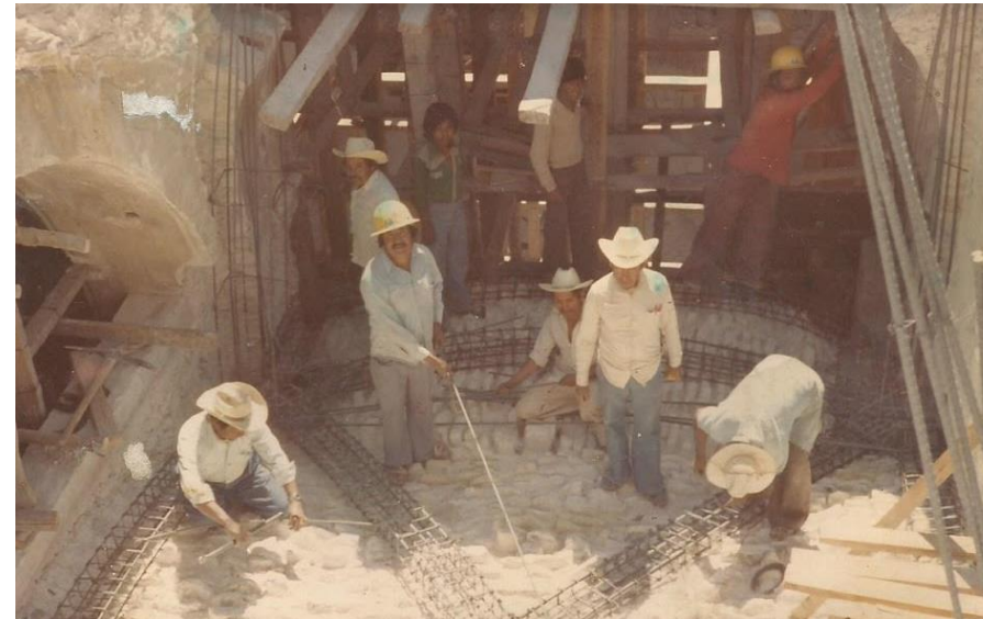
Figura 36. Jimenez, B. () Reconstrucción de cúpula de la Iglesia de San Felipe y Santiago Apóstol.
