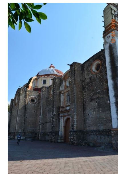
FOTOGRAFÍA 10. Fachada norte del templo
