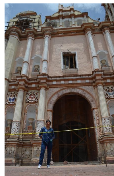
Fotografía 11. Obra en proceso sobre fachada principal.
