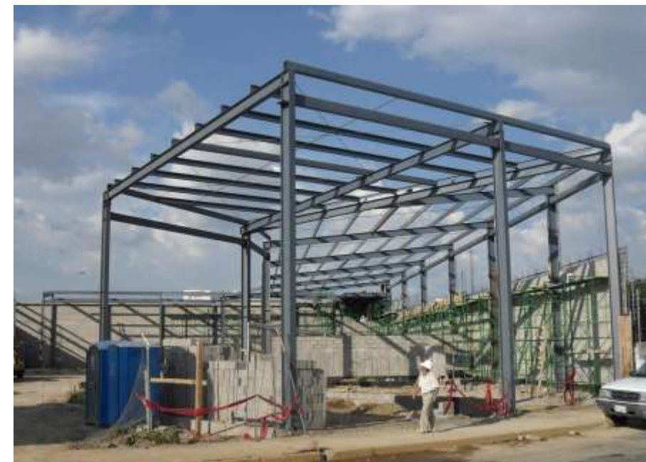
IMAGEN N. 85 ESTRUCTURA A BASE DE MARCOS RÍGIDOS AROCHE 2022.
