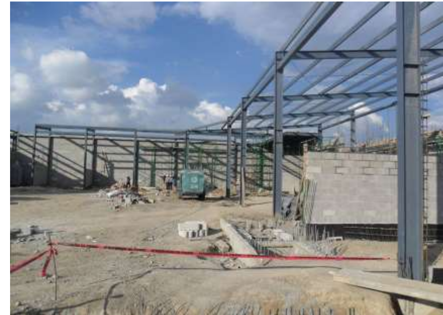
IMAGEN N. 86 ESTRUCTURA A BASE DE MARCOS RÍGIDOS AROCHE 2022.
