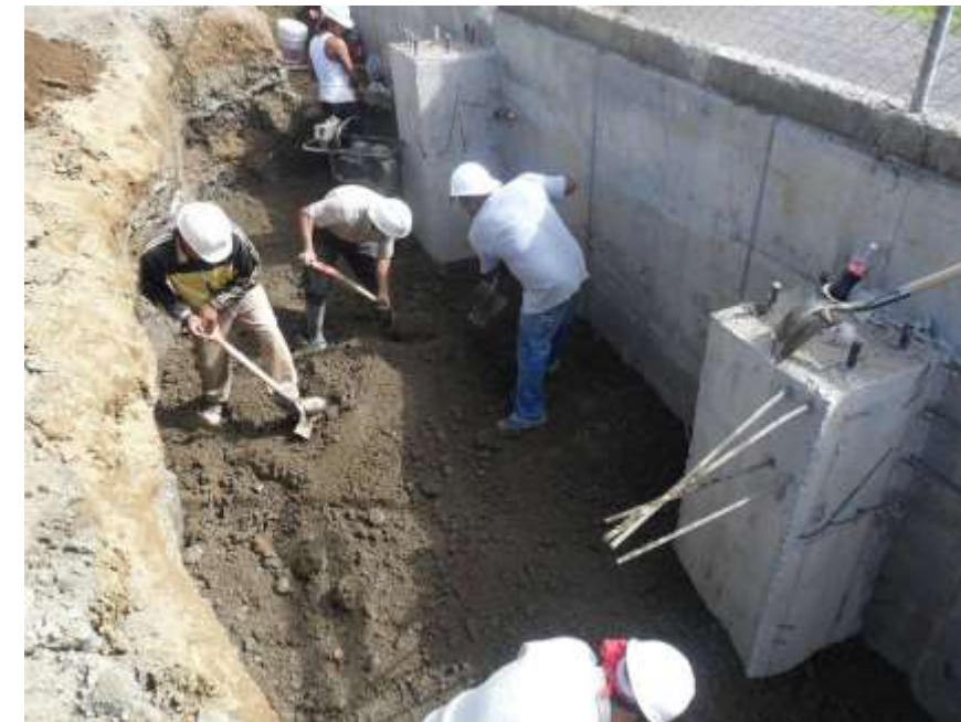
IMAGEN NO 87 REPORTE FOTOGRÁFICO DE ZAPATAS AISLADAS AROCHE 2022.
