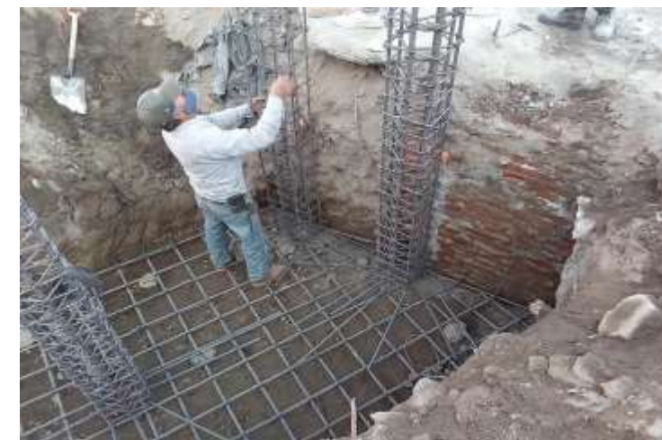
IMAGEN N. 83DETALLE DEL ARMADO DE COLUMNAS AROCHE 2022
