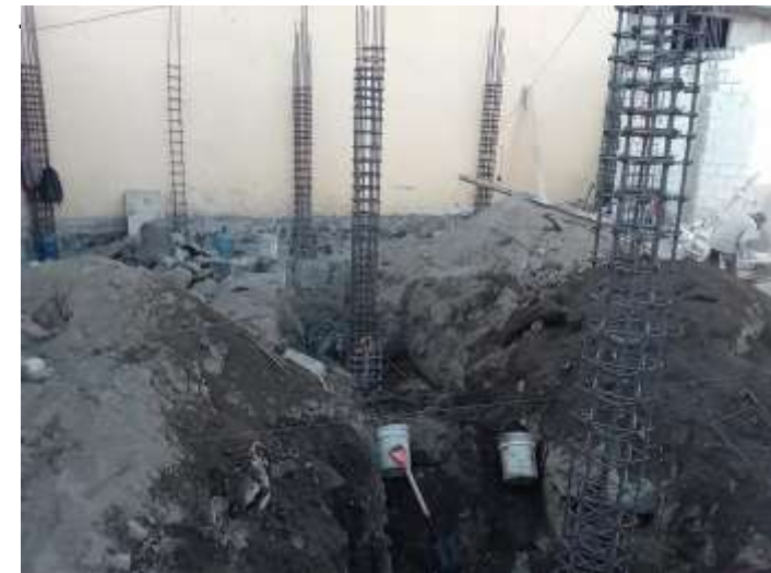
IMAGEN No. 82 REPORTE FOTOGRÁFICO DE ZAPATAS AROCHE 2022
