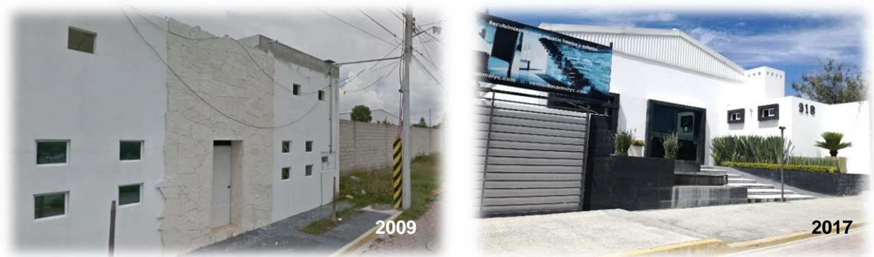
Imagen 40. Desarrollo progresivo de la infraestructura interna de la Fábrica Marmolyc de 2009-2017.
