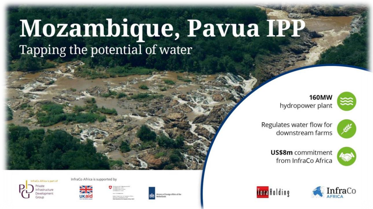
Imagen 7. Proyecto hidroeléctrico Pavua, Mozambique. Fuente: INFRACO, 2018.
