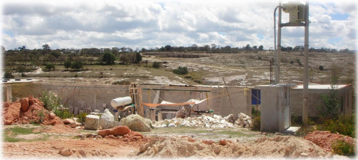
Imagen 32. Taller artesanal carente de infraestructura básica. Fuente: Propia, 2017.
