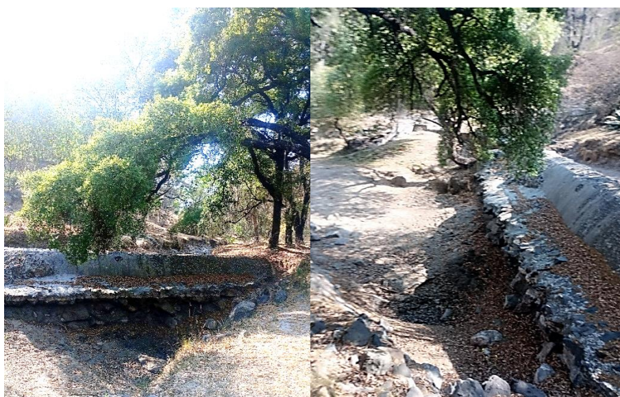
Ilustración 13. Presa de la Texmolera. Aprovechamiento hídrico realizado en la época colonial.
